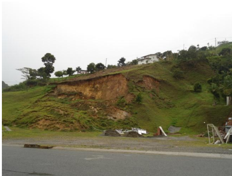
Figura 3.17. Deslizamento de tipo rotacional.
