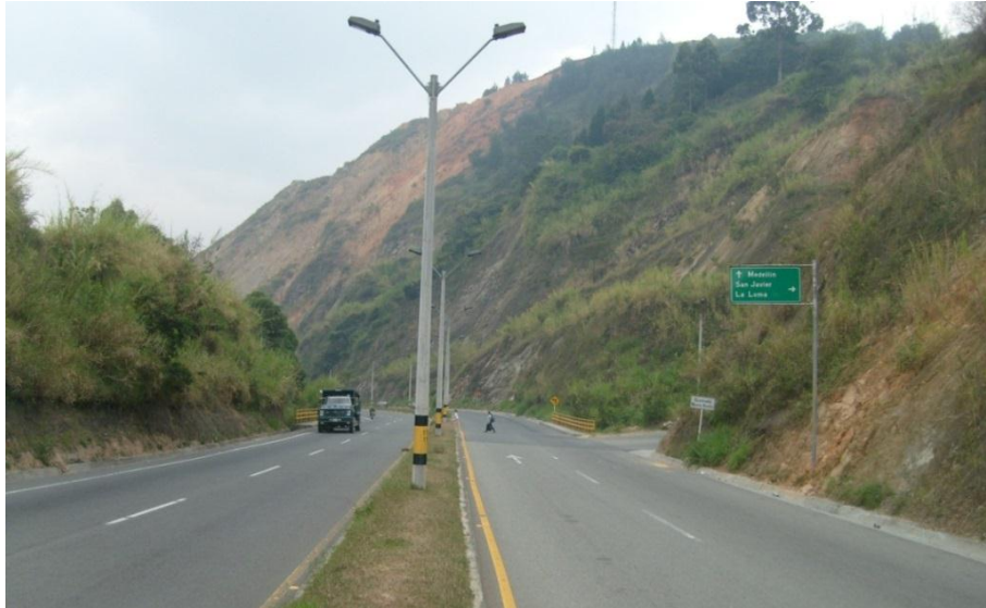
Figura 3.13. Panorâmica da estrada no setor oriental-Trecho 2
