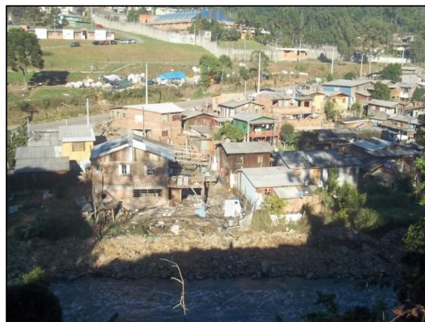
Figura 4: Bairro Reolon próximo do Aterro Sanitário São Giácomo. SCHLINDWEIN, J.R. 01/06/2012.
