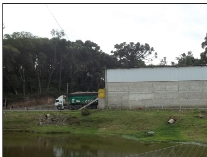
Figura 49: Carreta saindo da estação de transbordo. SCHLINDWEIN, J.R. 25/05/2012.
