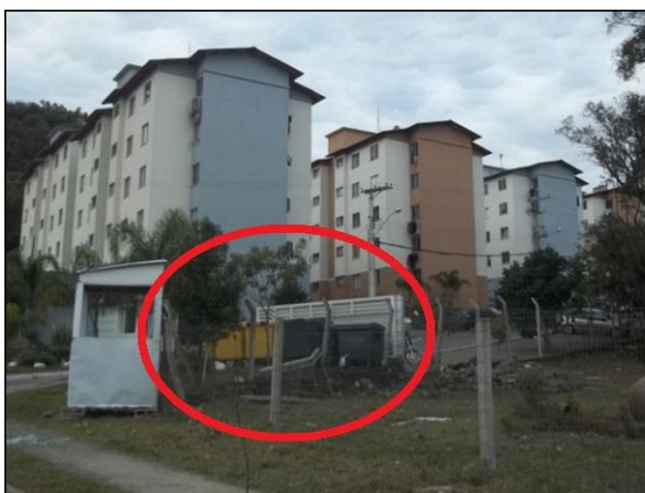
Figura 18: Contêineres posicionados para depósito de resíduos dos condôminos. SCHLINDWEIN, J.R. 03/06/2012.
