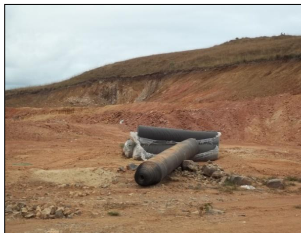
Figura 52: Polietileno de alta densidade a ser utilizado na expansão da célula. SCHLINDWEIN, J.R. 25/05/2012.
