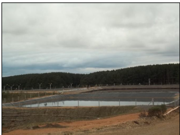
Figura 53: Lagoa de estabilização para tratamento do líquido percolado. SCHLINDWEIN, J.R. 25/05/2012.
