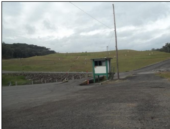
Figura 47: Entrada do Aterro Sanitário São Giacomo. SCHLINDWEIN, J.R. 25/05/2012.
