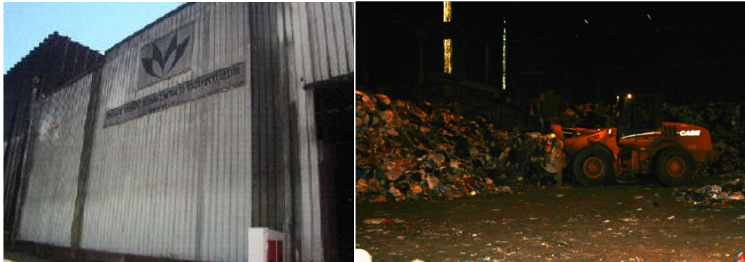
Figura 6.17 – Fachada frontal da IRR Ceilândia. Foto: PDRS DF. Área de recepção dos resíduos e alimentação as linhas de produção da IRR Ceilândia – Brasília – 2012. Foto: Kátia Campos.
