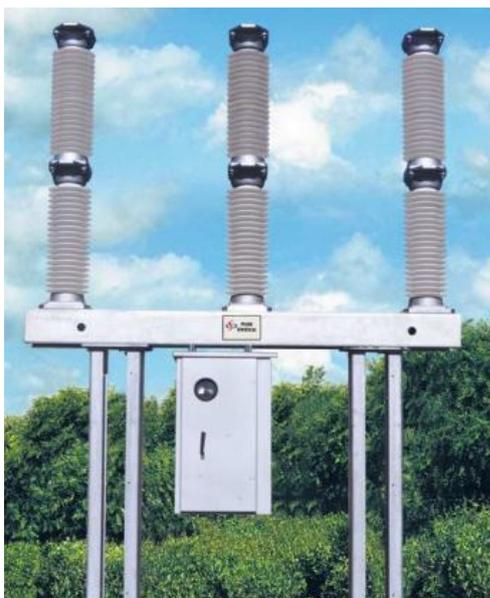
Figura 2. 2 - Disjuntor a pequeno volume de óleo, fonte: Lima (2010).
