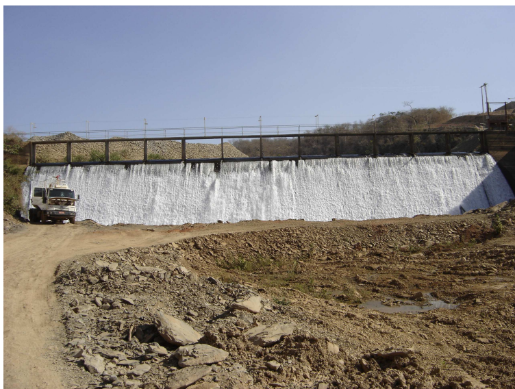
Foto 2: Vista da barragem existente – UHE Mambaí. Fonte: própria da autora, 09/10/2007.
