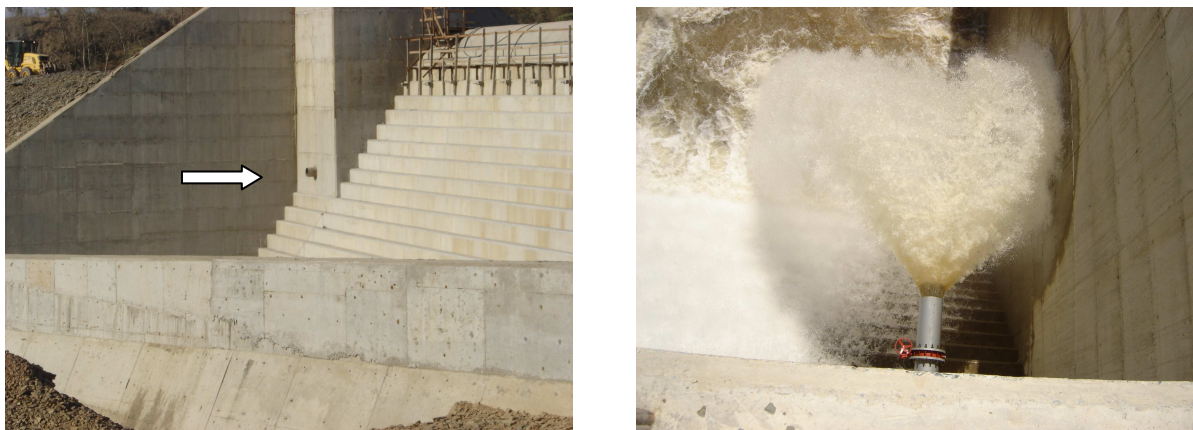
Foto 3: Dispositivo para manutenção da vazão remanescente com 0,5 m 3 /s. Fonte: própria da autora, 10/10/2007 e 04/03/2007.
