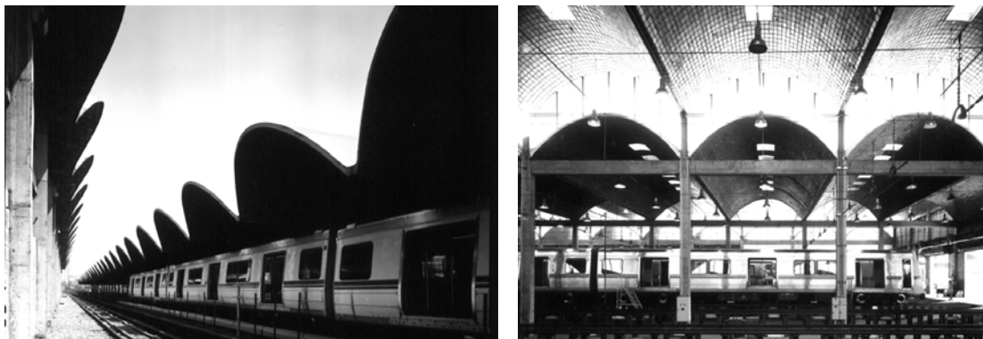
Figura 76 e 77. Abóbadas autoportantes simples dos hangares do metrô de Rio de Janeiro.
