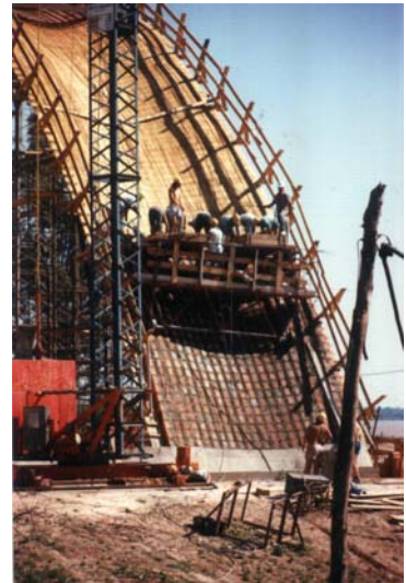
Figuras 63 e 64. Da esquerda para a direita. As costelas da fôrma começam a ser revestidas de tábuas de madeira. A abóbada de tijolo começa a ser construída pelos operários.
