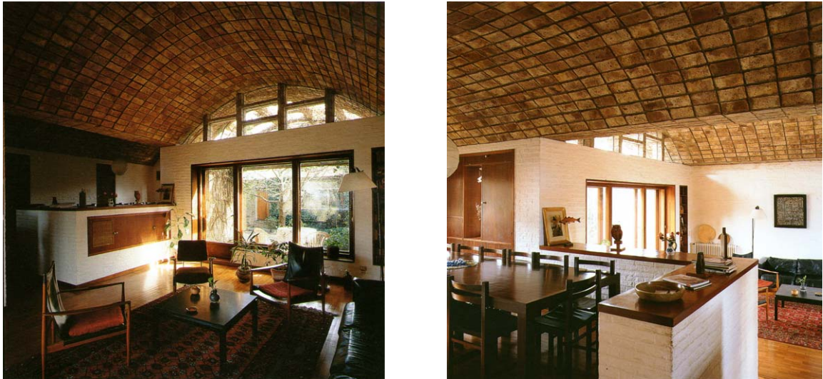
Figura 88 e 89. Da esquerda para a direita. Casa Dieste. Interior do estar com laje horizontal entre abóbadas. Vista da sala de jantar.
