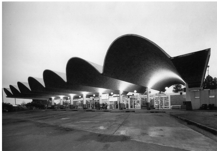
Figura 102. Rodoviária de Salto. Vista do terminal concluído.
