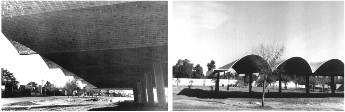
Figuras 100 e 101. Rodoviária de Salto. Da esquerda para a direita. Vista das abóbadas em balanço. Vista exterior do conjunto.
