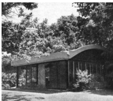
Figura 39. Arq. Antonio Bonet Castellana. Terminação da cobertura da casa Berlinghieri que esconde a espessura das abóbadas de tijolo.
