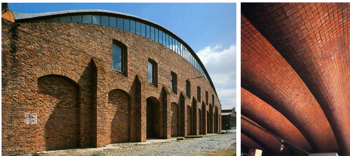
Figuras 58 e 59. Da esquerda para a direita. Vista da fachada do depósito. Vista interior das abóbadas de dupla curvatura.
