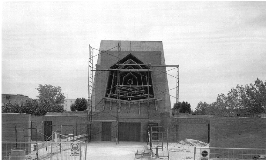
Figura 156. Igreja Mãe do Rosário. Fachada principal com a rosácea em cerâmica armada em construção.
