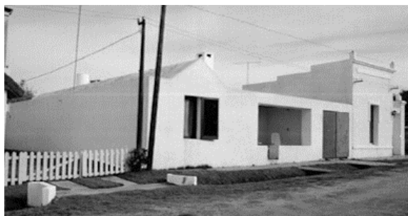
Figura 136. Casa de veraneio de Dieste. Fachada da casa e cobertura da primeira habitação com laje plissada.
