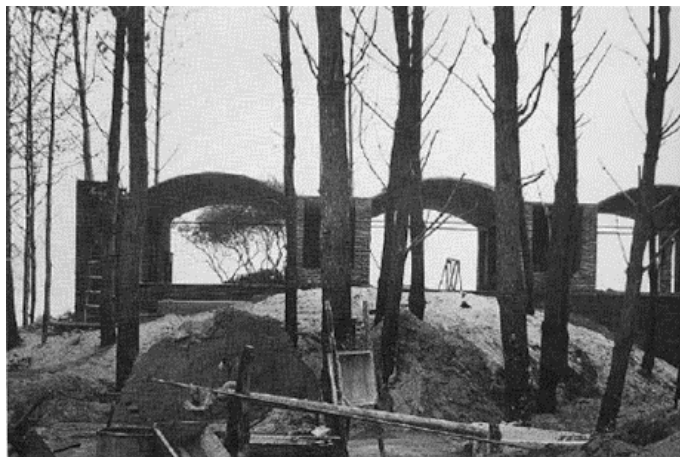
Figura 37. Arq. Antonio Bonet Castellana. Casa Berlinghieri durante sua construção com as delgadas abóbadas de tijolo desenhadas por Dieste.
