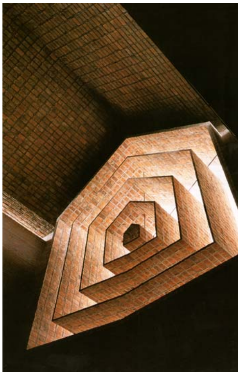
Figura 148. Igreja de São Pedro. Imagem da rosácea construída em cerâmica armada.
