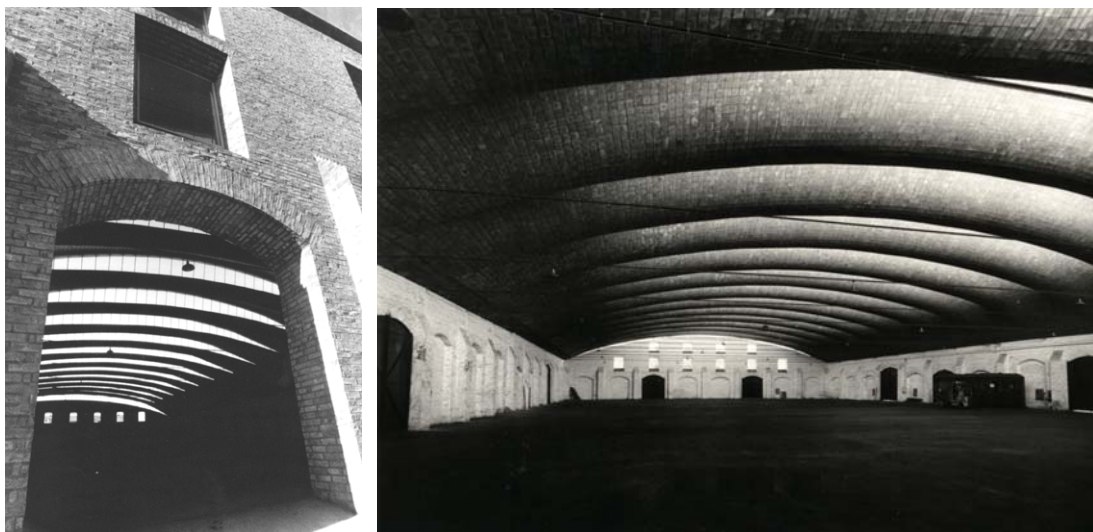
Figuras 60 e 61. Da esquerda para a direita. Vista de um dos pórticos de entrada e vista interior das abóbadas de dupla curvatura.
