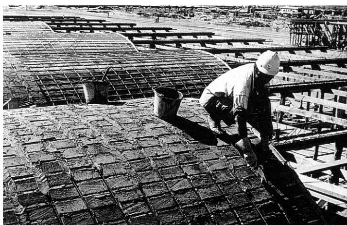
Figura 36. Colocando a argamassa entre tijolos, cobrindo as armaduras de aço. Ceasa de Porto Alegre.
