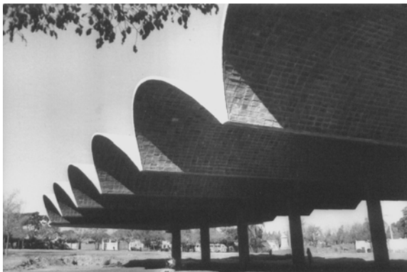
Figuras 98 e 99. Rodoviária de Salto. Da esquerda para a direita. Vista das abóbadas concluídas. Vista da mísula que sai do pilar e onde apóia a viga que suporta a viga-laje horizontal.
