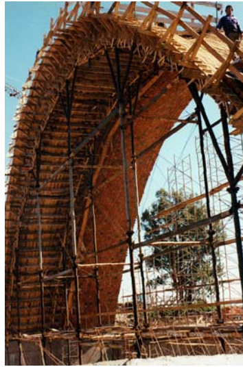
Figuras 65. Primera seção da abóbada finalizada e a fôrma em posição para realizar a segunda seção.
