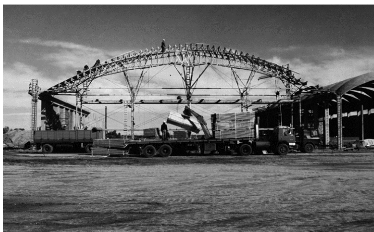
Figura 43. Formas de madeira e metal construídas para a realização das abóbadas de tijolo.
