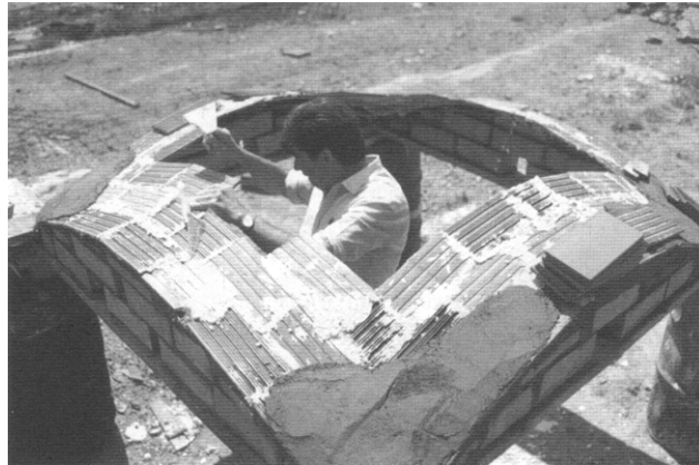
Figura 33. Construção de uma abóbada catalã.
