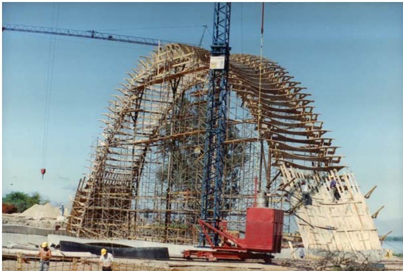
Figuras 63 e 64. Da esquerda para a direita. As costelas da fôrma começam a ser revestidas de tábuas de madeira. A abóbada de tijolo começa a ser construída pelos operários.
