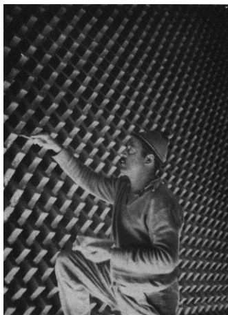
Figura 123. Igreja do Cristo Obreiro de Atlântida. Operário terminando o muro dos fundos da Igreja.
