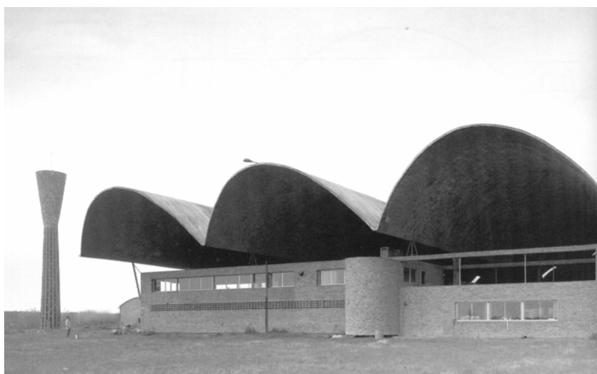
Figura 106. Agro-indústria Massaro. Conjunto de abóbadas sobre volume de escritórios. À esquerda, a torre de água de cerâmica armada.
