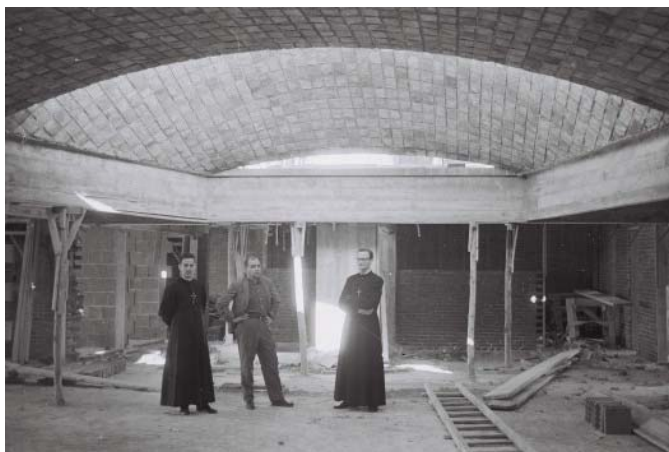
Figura 29. Clémot – Dieste – Montañez – Serralta arquitetos e engenheiros. Colégio La Mennais. Oratório em construção com abóbadas de tijolo.
