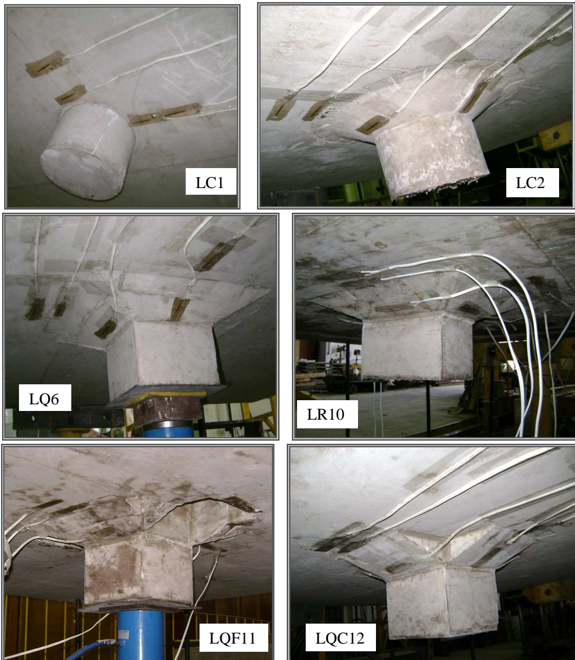
Figura 3.19 – Extensômetros fixados na face inferior das lajes, dentro e fora dos capitéis
