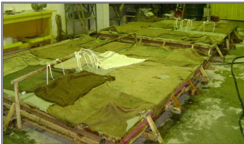
Figura 3.27 – Cura das lajes
