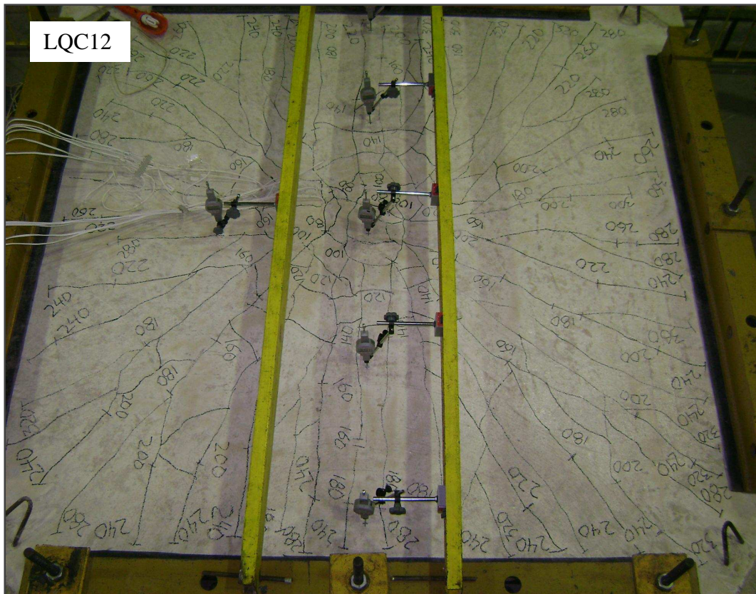
Figura 4.30 - Fissuras da laje LQC12 (com capitel cruciforme e relação h_H/l_H de 1:2)
