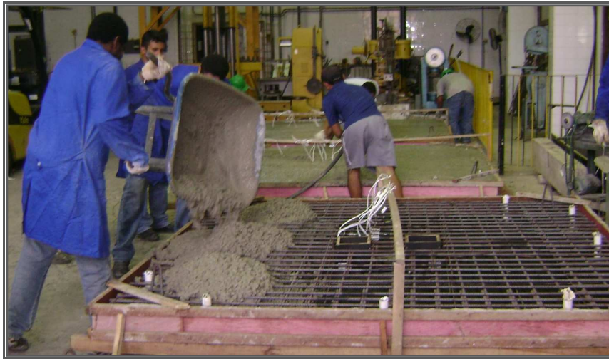
Figura 3.26 – Concretagem das lajes da terceira série
