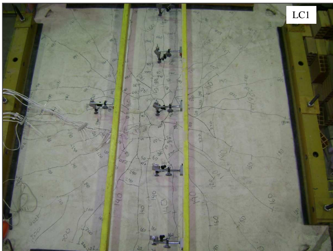
Figura 4.24 - Fissuras da laje LC1 (com pilar circular, mas sem capitel)
