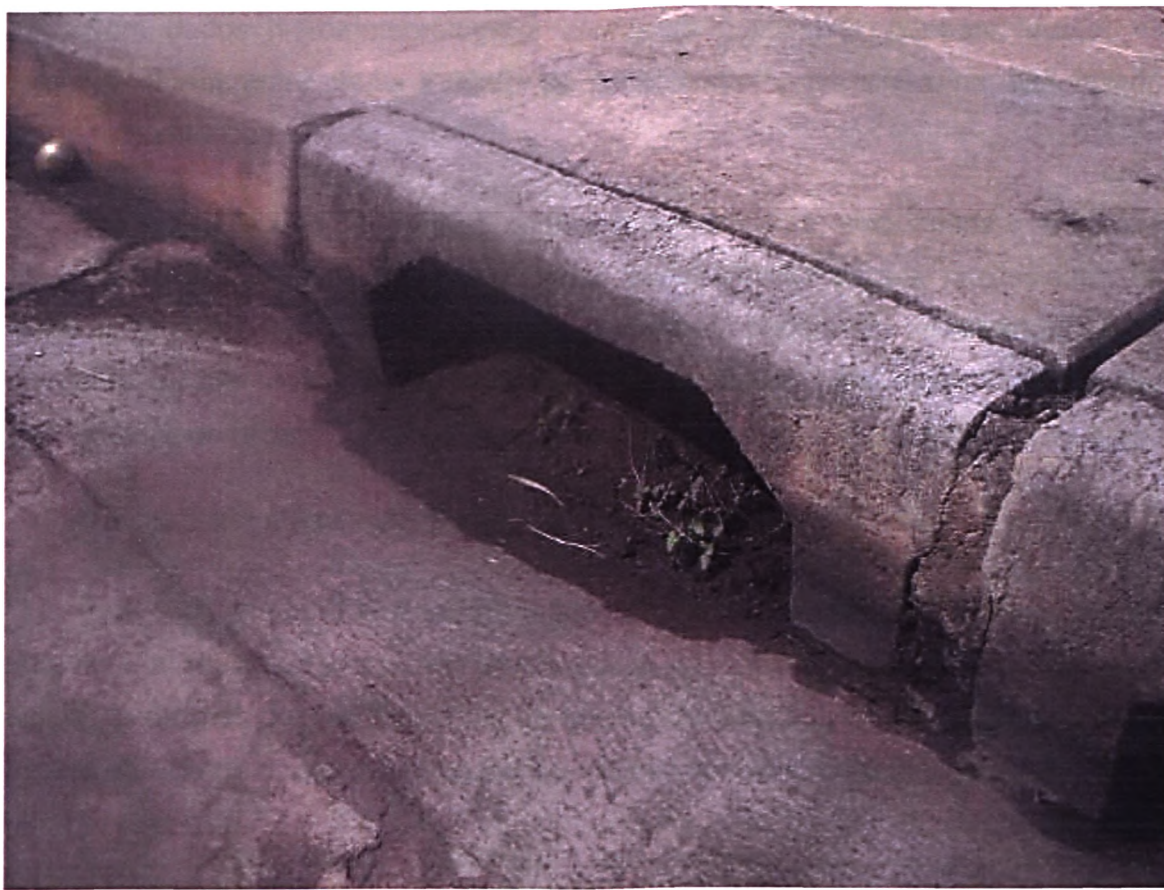
Foto 5.3: Boca de lobo entupida na área do Polo de Modas do Guará II (CHRISTOFIDIS, 2010).
