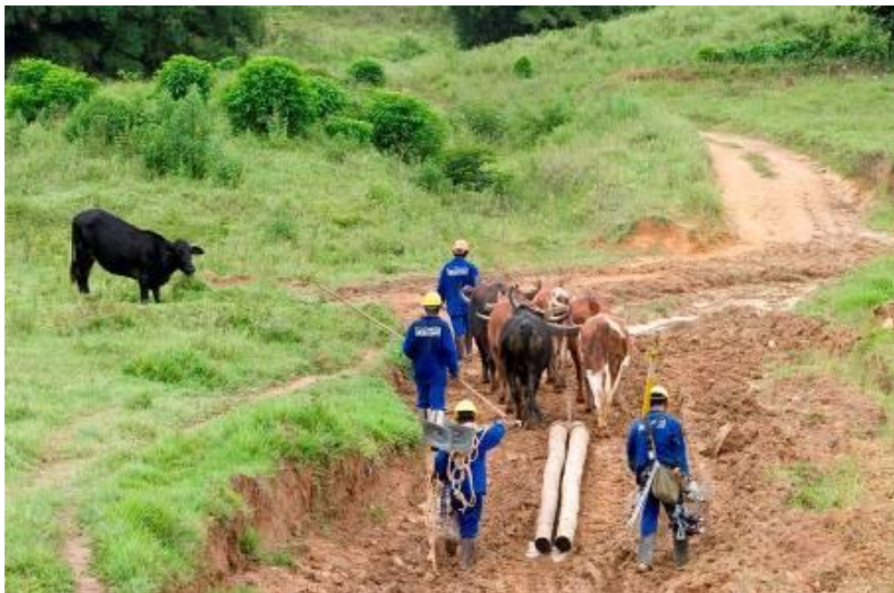
Figura 2 - Dificuldade de acesso e de transporte de materiais (poste) no estado de Minas Gerais – Utilização de tração animal.
