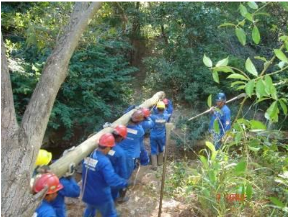
Figura 4 - Dificuldade de acesso e de transporte de materiais (poste) no estado de Minas Gerais – Utilização de mão de obra humana.
