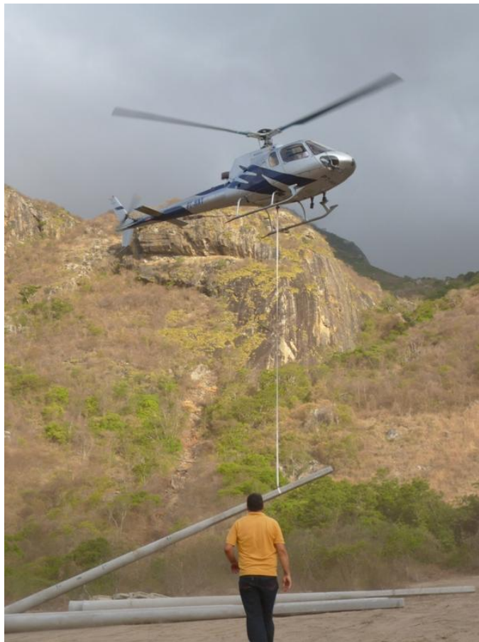
Figura 35 - Dificuldade de acesso, comunidades isoladas e novas tecnologias (poste de fibra de vidro), Povoado da Serra do Cafundó, município de Choró (CE)
