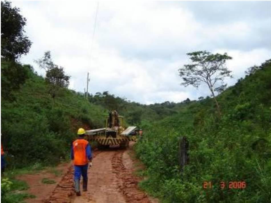
Figura 3 - Dificuldade de acesso e de transporte de materiais (poste) no estado de Minas Gerais – Utilização de trator.
