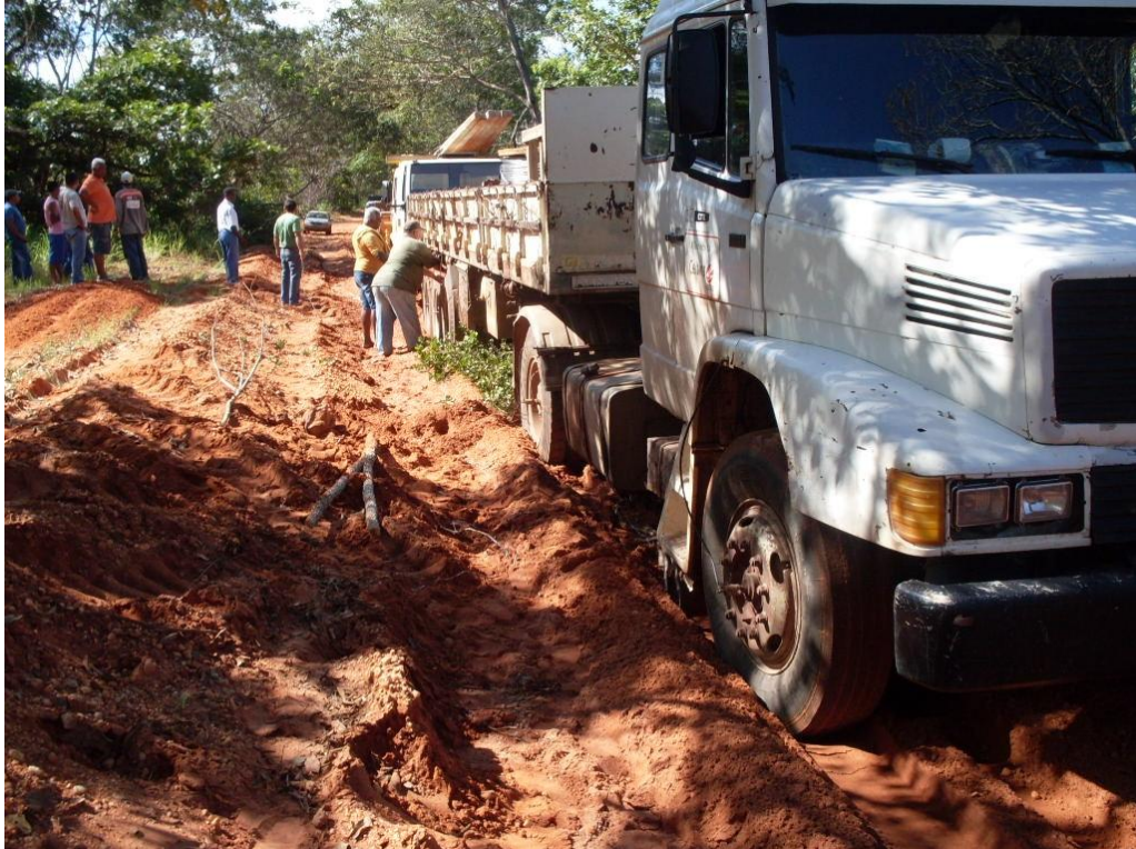
Figura 27 - Dificuldades de acesso, município de Maurilândia do Tocantins (TO) Fonte: Acervo fotográfico do Programa LPT (DPUE/SEE/MME)
