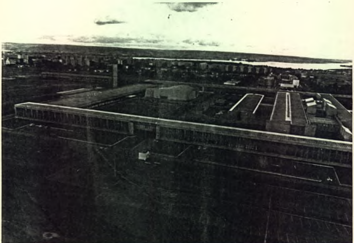
Fotografia 4: Vista total do Pavilhão do Comando
