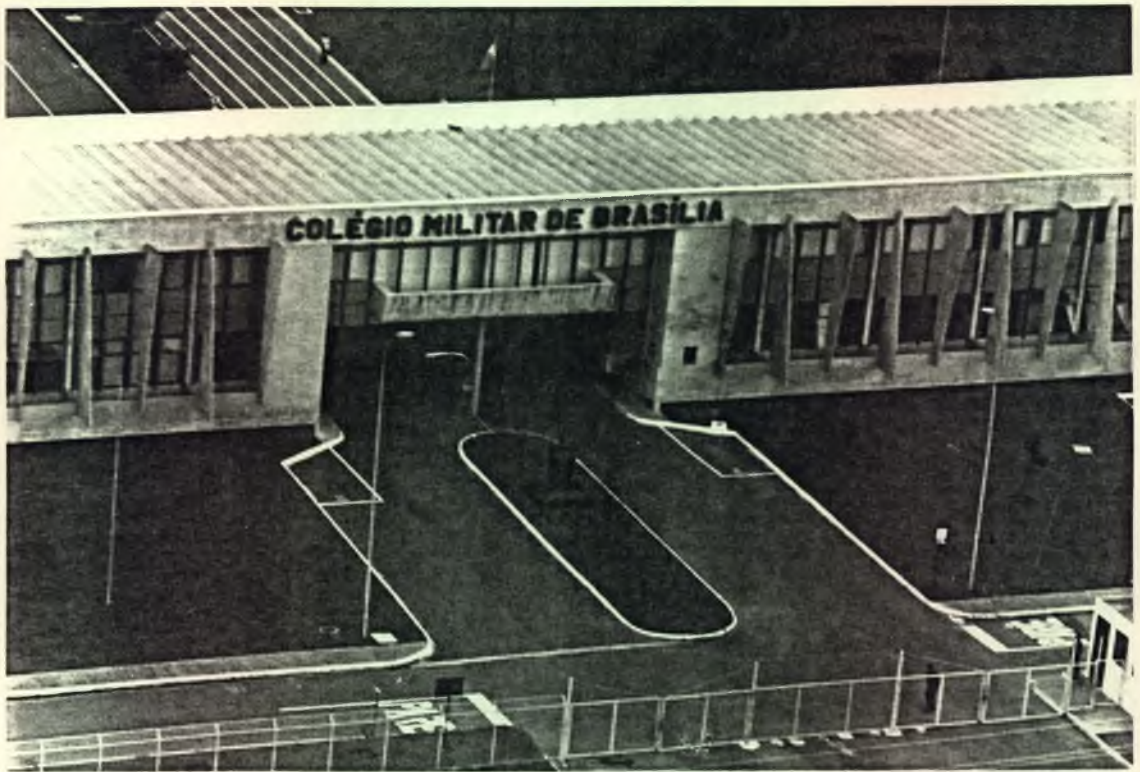
Fotografia 3: Entrada Oeste do CMB (Pavilhão do Comando)
