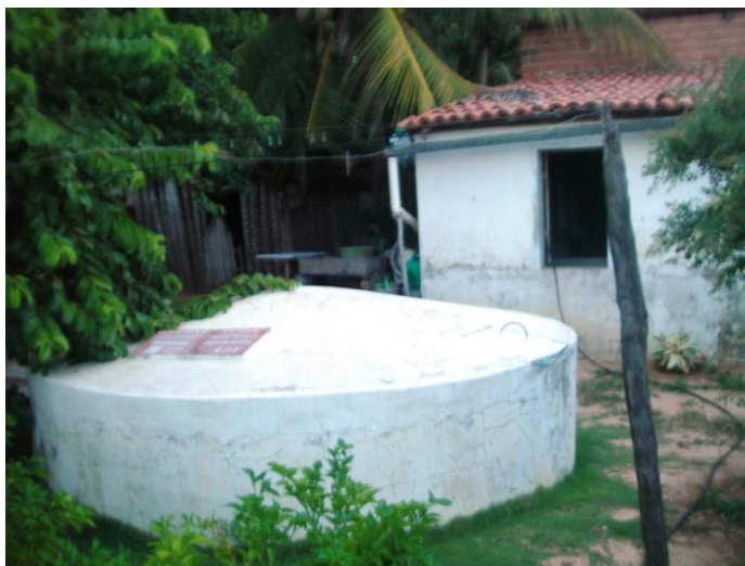
Figura C16 – Cisterna de placas Fonte: autora
