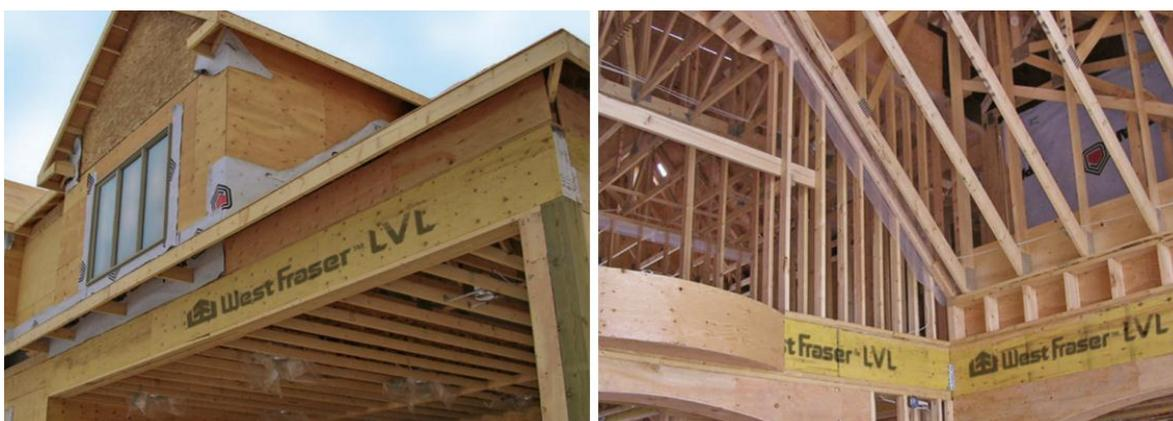
**Figura 15.** Painéis LVL utilizados em estruturas e telhados (WEST FRASER, 2007).
