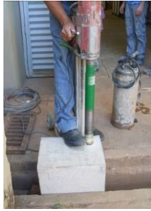
Fixação da extratora no chão
