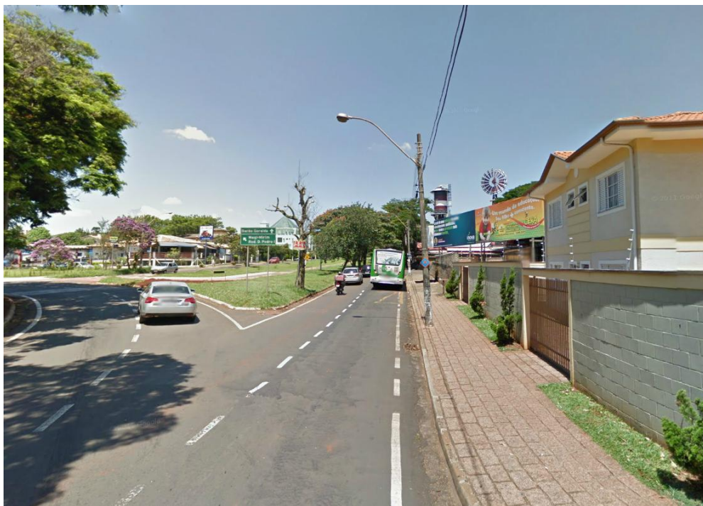
Figura 4.2: Vista parcial da Av. Prof. Atílio Martini (1).
