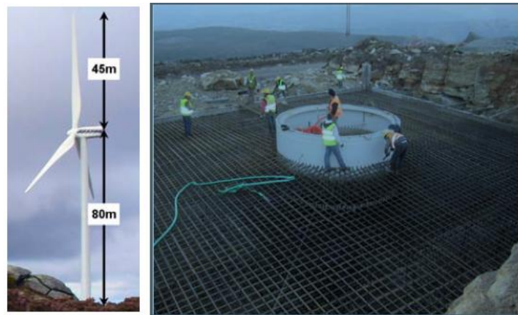
Figura 5.11 – Torre eólica e construção da fundação (Azenha, 2009).
