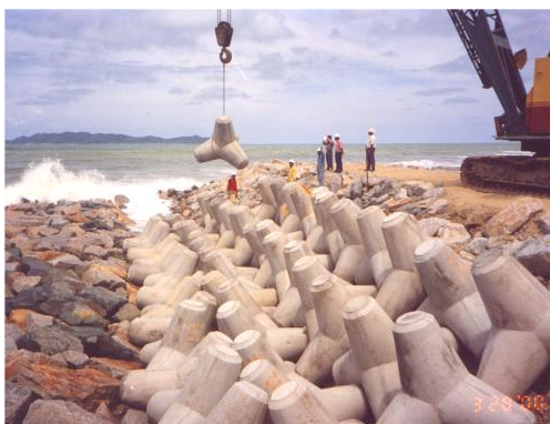
Figura 5.7 - Construção de um quebra-mar – colocação de tetrápodes (Azenha et al. , 2011). Azenha et al. (2011) analisou os efeitos térmicos de um tetrapodo construído conforme a geometria mostrada na figura 5.8, utilizando o software ADINA com as propriedades de uma estrutura real, como mostra a tabela 5.1.
