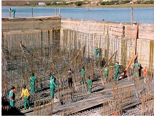
Figura 1.2 – Preparação dos blocos de fundação da Ponte Juscelino Kubistchek para concretagem (Pedroso, 2000).
