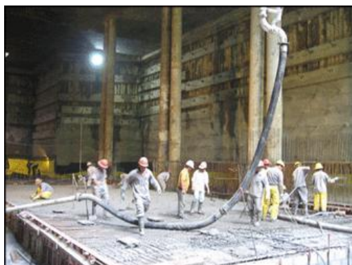
Figura 1.3 – Concretagem do Bloco 3 da Estação Faria Lima – Linha 4 Amarela em São Paulo (Albuquerque, 2009).
