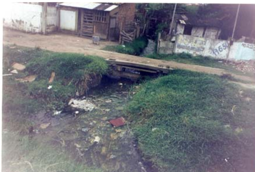
Fotografia de casas construídas em área aterrada da lagoa, às margens do canal de drenagem
