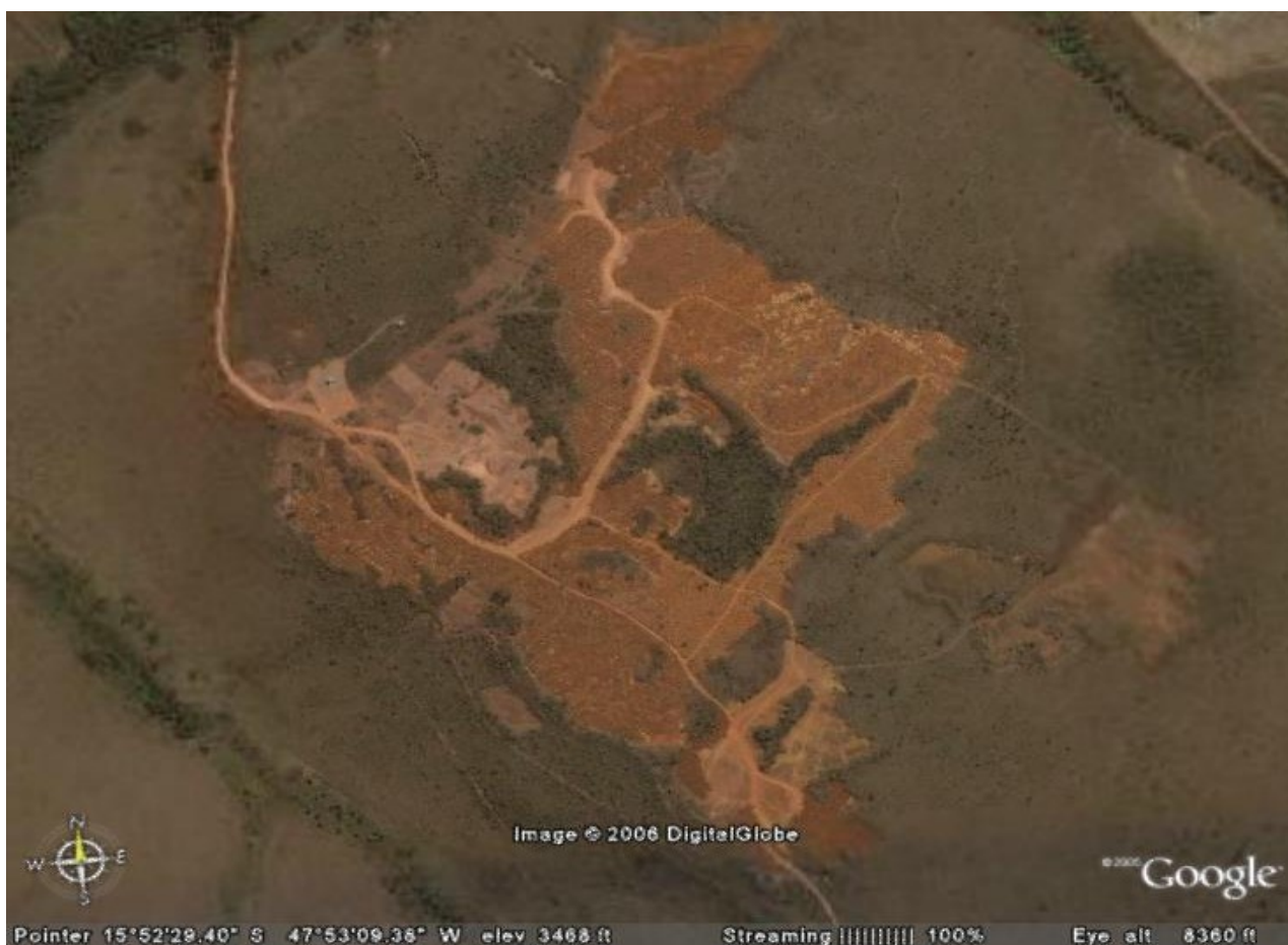
Figura 3 – Imagem de satélite da área antes da recuperação (detalhe)
