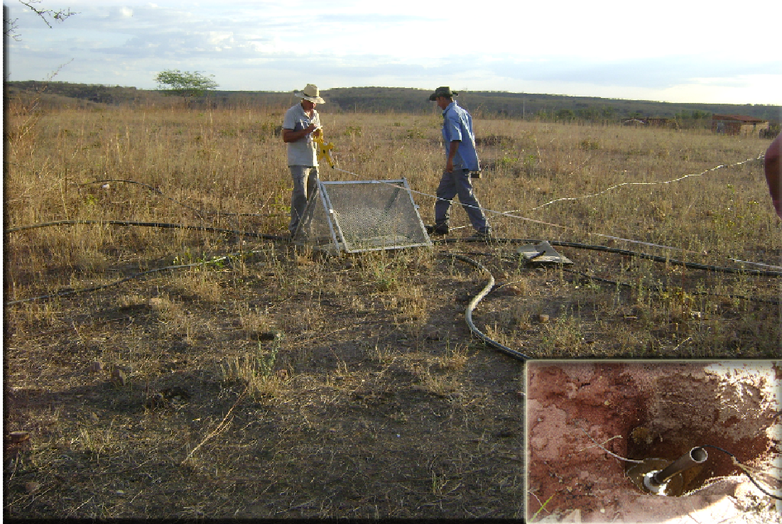
Figura 4.1.5. Instalação de eletrodo. Detalhe para a disposição do eletrodo mergulhado na mistura de bentonita saturada em água.
