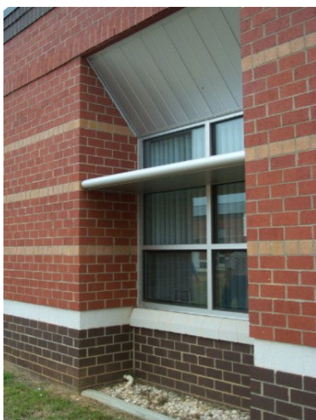
Figura 3.8: Exemplo de aplicação da prateleira de luz. Fonte: www.ncgreenbuilding.org
