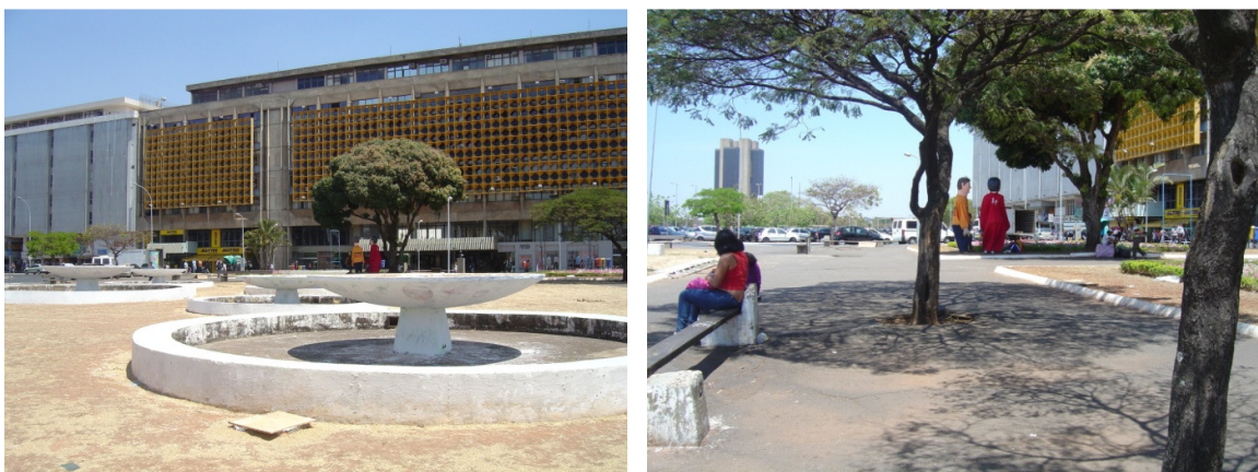
Figura 109 - Brasília, Brasil. Praça sul da Plataforma Rodoviária, em agosto de 2010.
