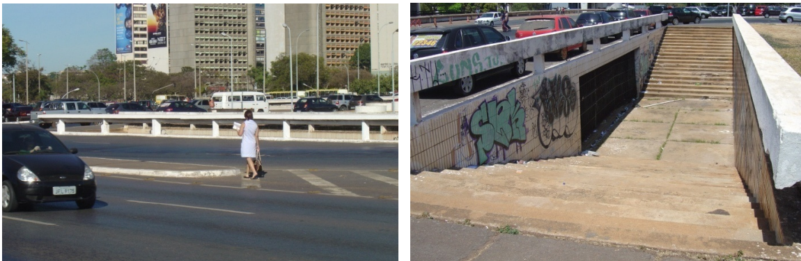
Figura 131 - Brasília, Brasil. Conexão da praça sul com o Touring. O guarda-corpo circunda a passagem que leva ao Setor Cultural Sul, hoje fechada, e funciona como barreira. Agosto de 2010.
