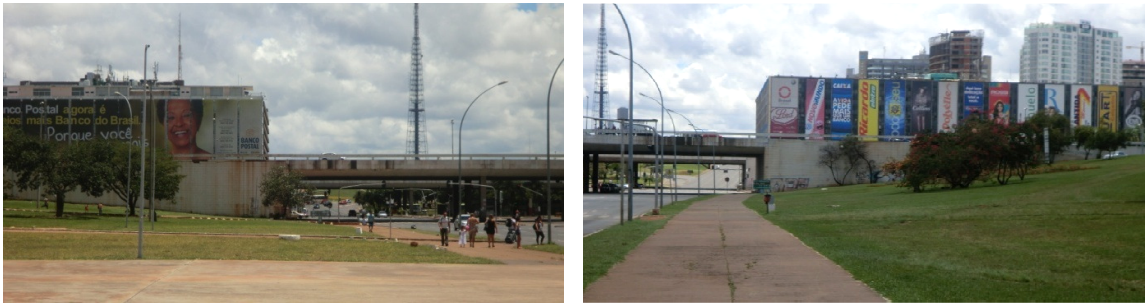
Figura 138 - Brasília, Brasil. Pontos possíveis de circulação vertical entre Plataforma Rodoviária e lado leste do Eixo Monumental. Março de 2012.
