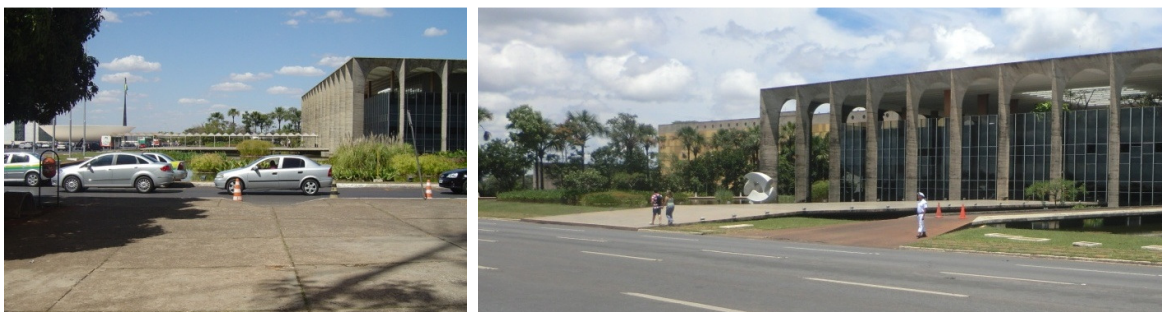
Figura 167 - Brasília, Brasil. Eixo Monumental leste. Fim da calçada sul. Justamente quando se chega no belíssimo edifício do Palácio do Itamaraty, a continuidade de trajeto se perde. Setembro de 2010. A calçada do Itamaraty tem apenas 3m de largura e sua rampa dá direto no asfalto.
