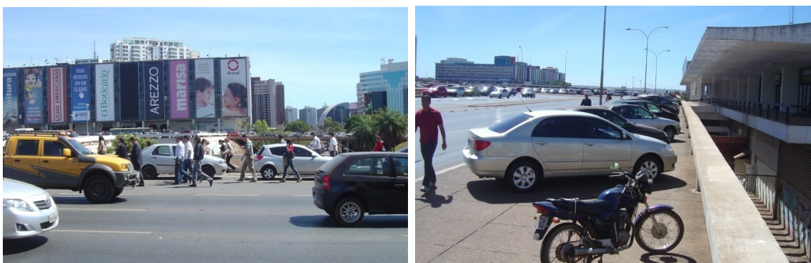
Figura 128 - Brasília, Brasil. Conexão da Plataforma Rodoviária com o Setor Bancário Norte (esquerda) e Sul (direita). Agosto de 2010.
