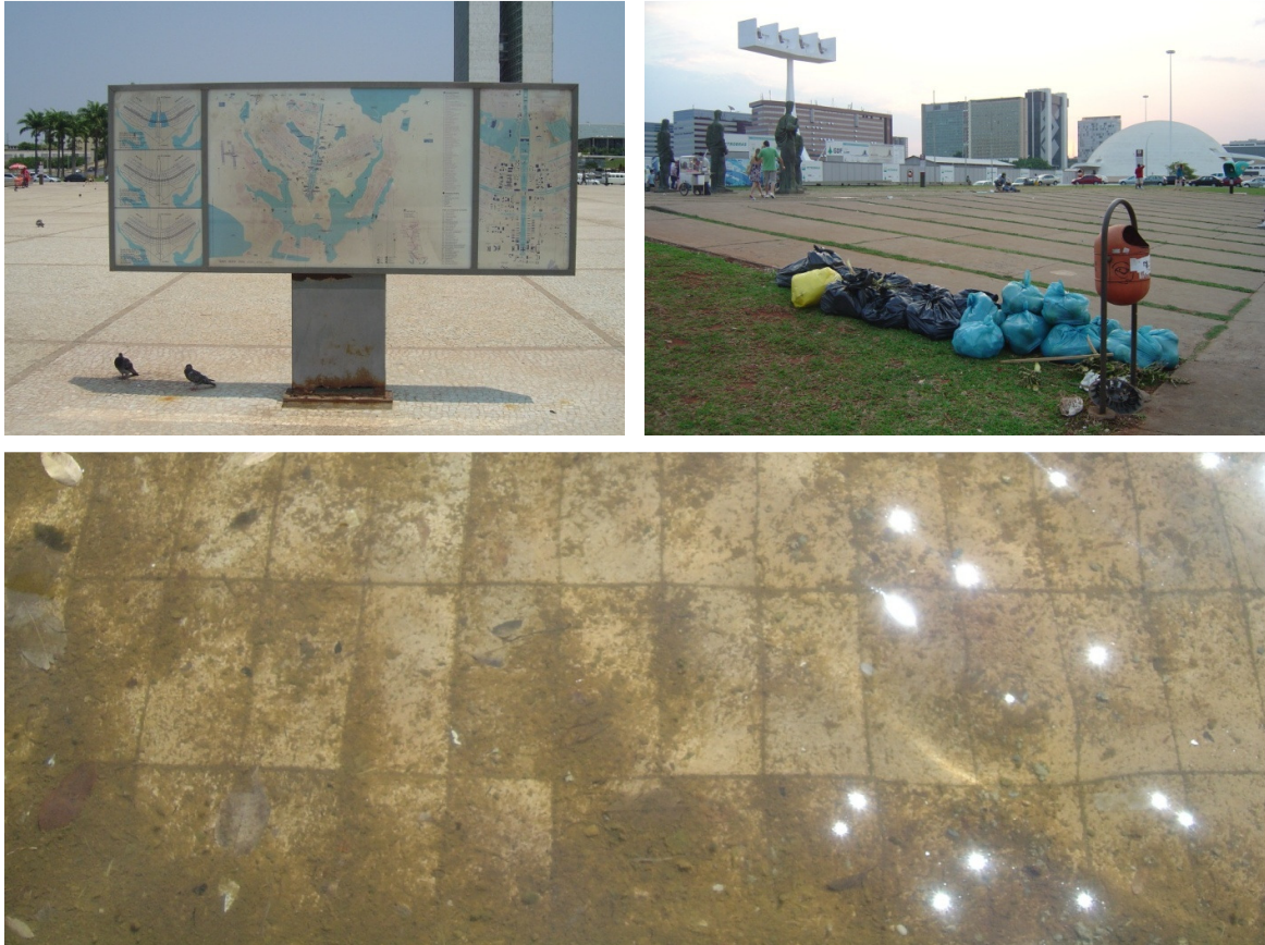
Figura 182 - Brasília, Brasil. Eixo Monumental leste. Problemas de manutenção/conservação. Setembro de 2010 e março de 2012.
