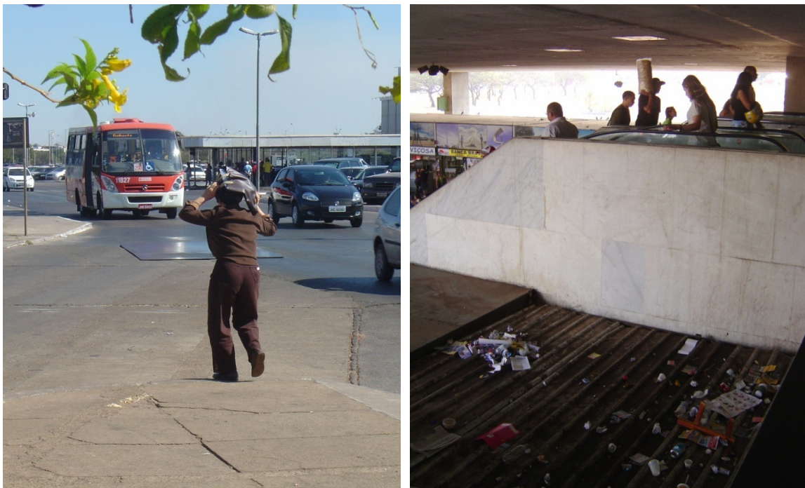
Figura 2 - Brasília, Brasil. Na Plataforma Rodoviária (esquerda), não há alternativa para o trajeto dessa senhora, que inclui passar sob o sol de três da tarde do mês de agosto, numa calçada deteriorada e descontínua, e atravessar onde não há faixa de pedestres. Na Rodoviária do Plano Piloto (direita), os frequentadores não têm escolha senão conviver com a sujeira.
