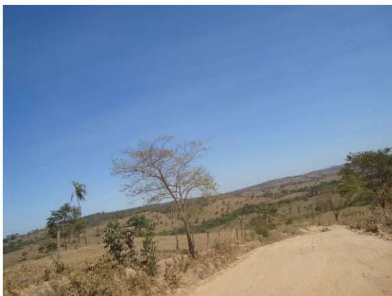
Foto 1. Estrada Carmo do Rio Verde/São Patrício.
