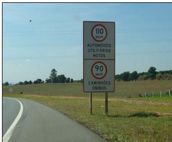
Figura 2.4 - Falta de suportes colapsíveis
