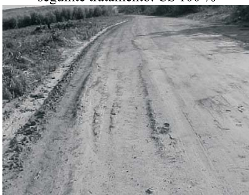
Trilhas de roda com baixo nível de severidade, presentes no trecho com o seguinte tratamento: LC 70 % - CS 30 %
