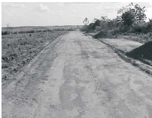
Seção transversal e drenagem, executadas de maneira correta
