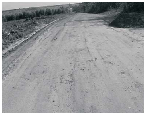
Trilhas de roda de baixo nível de severidade, observadas no trecho com o seguinte tratamento: CS 100 %
