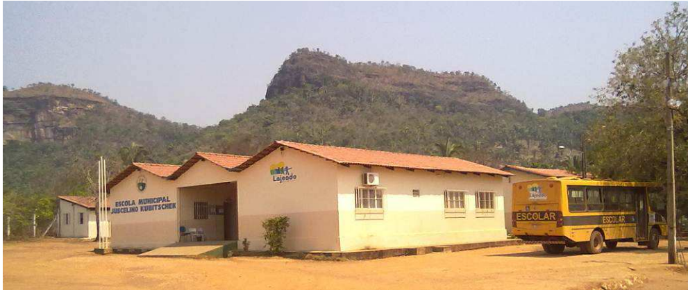
Figura 6.2: Escola Municipal Juscelino Kubitschek - Lajeado - TO
