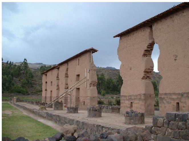
Fig. 14 Vista da estrutura principal, conhecida como uma *kallanka* no Templo de Wiracocha, Racchi, Cuzco. Pode-se observar a parte inferior, de pedra, as bases das colunas e a parte superior, de adobe.
