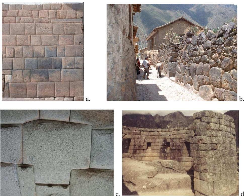
Fig. 55 Quatro exemplos de estilos diferentes de cortar pedras para muros e paredes Incas. a. semi atijolado, Cusco; b. Celular e ciclopeo Ollantaytambo, observar a curvatura das paredes; c. Moldurado Rua Hatunrumiyoq, Cusco; d. Torreón, Machu Picchu, Cusco. Fonte: Fotos de Mackay, 2007, 2009 e 1987.
