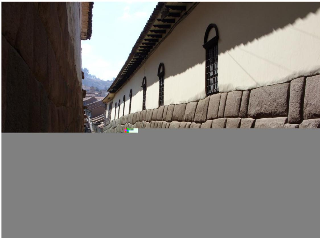
Fig. 19a Rua Hatunrumiyoc na qual pode-se observar o estilo de construção poligonal Inca na parte inferior da vila e a superposição de uma estrutura colonial de adobe, Cuzco.
