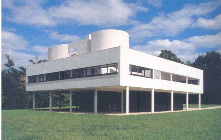
Fig. 18 Villa Savoye, Poissy, de Le Corbusier. Observar o uso de pilotis distribuídos simetricamente como suporte para uma estrutura com um espaço/pátio interno no segundo andar.
