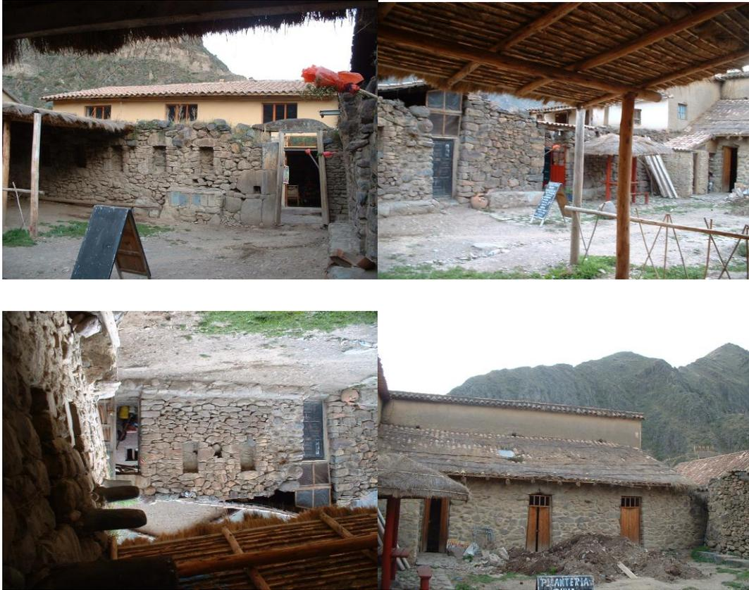
Fig. 91: Exemplo do interior de uma *kancha* (em reformas), No. 10 Ollantaytambo . Observar as quatro estruturas retangulares, o pátio central, os nichos nas paredes internas, a inclinação dos muros pelo lado interno e os pontos para atadura do telhado.
