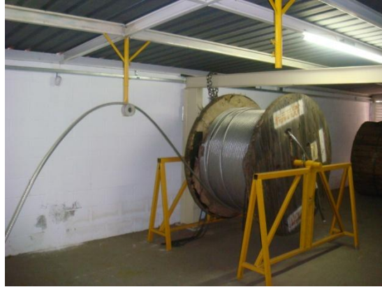
Figura 3.18 – Retirada do cabo condutor da bobina.
