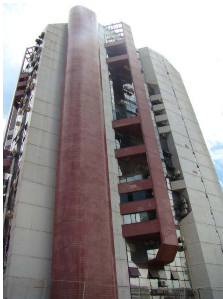
Figura 5.16 - Foto da Estação 04.
