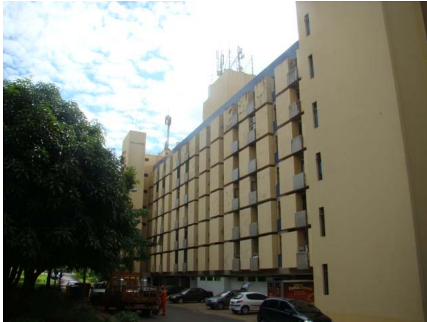
Figura 5.6 - Foto da Estação 02.
