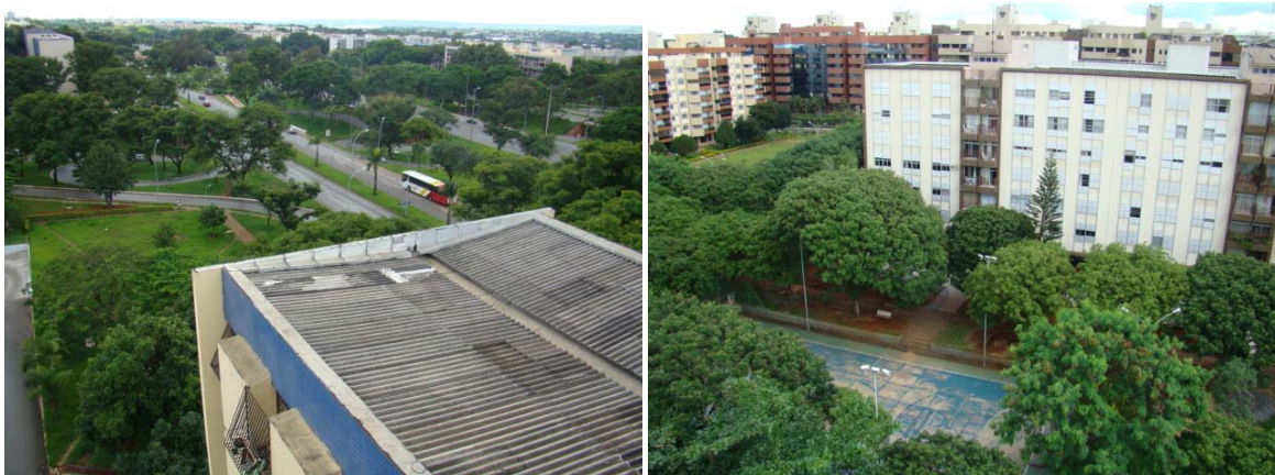
Figura 5.8 - Morfologia da região da Estação 02.
