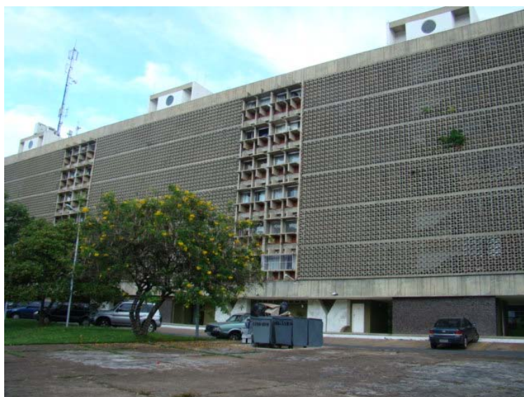
Figura 5.1 - Foto da Estação 01.
