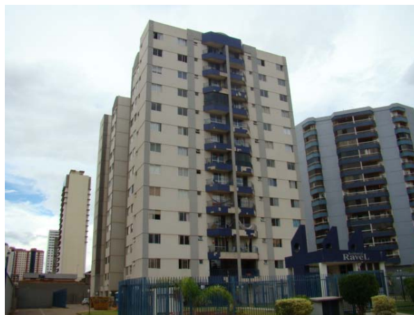
Figura 5.11 - Foto da Estação 03.
