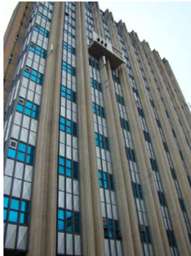
Figura 5.21 - Foto da Estação 05.
