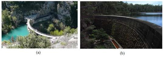
Figura 2.4 - (a) Barragem em arco Zola; (b) Barragem em arco Parramata (Meliço, 2010)
