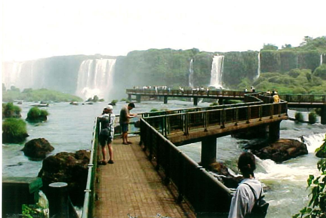
Fotografia nº 25 – Vista das passarelas no Rio Iguacu (Foto de Maria Luiza N. Paes - 26/02/2002).
