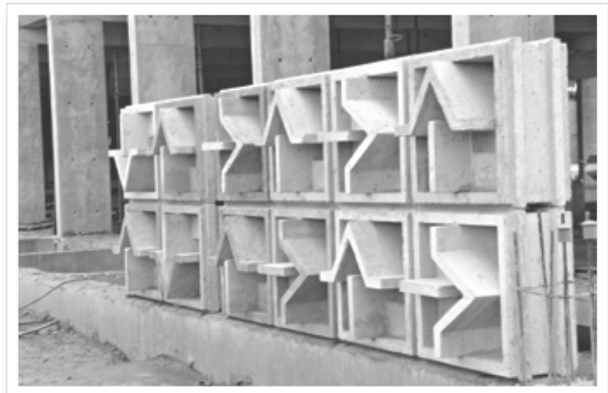
109. Instituto de Química da UnB - Detalhe dos cobogós
