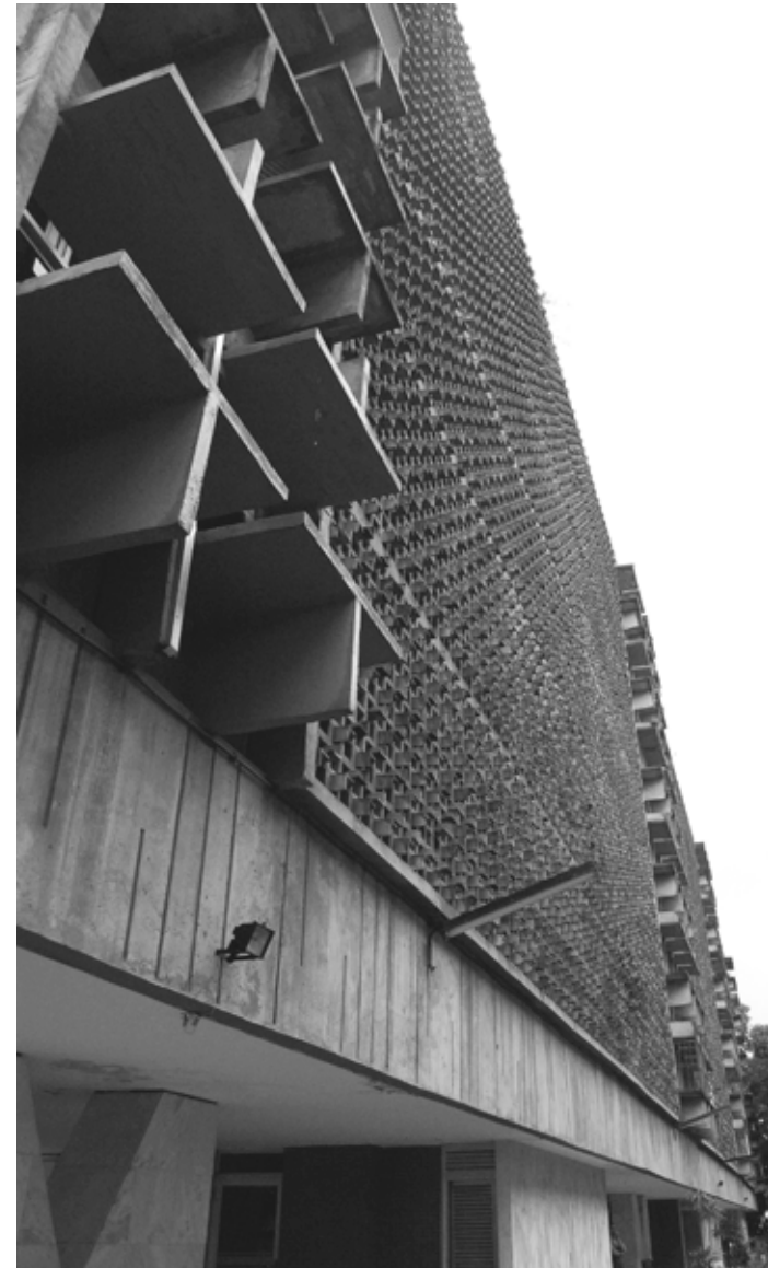
51. Bloco tipo A-22. Detalhe fachada posterior. Fonte: autor
