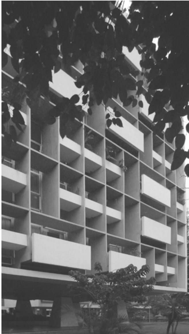
118. Fachada principal - Bloco tipo AM-3, SQS 312 Fonte: autor
