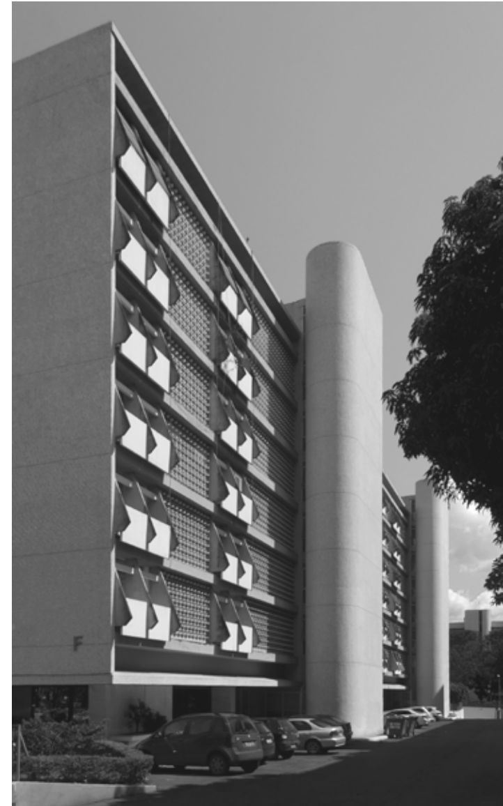
76. Fachada posterior. Bloco tipo A-25 Fonte: autor
