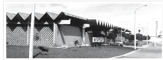
34. Garagem da Caixa, 1968. Detalhe fachada - acesso. Fonte: acervo de Marcílio Mendes Ferreira
