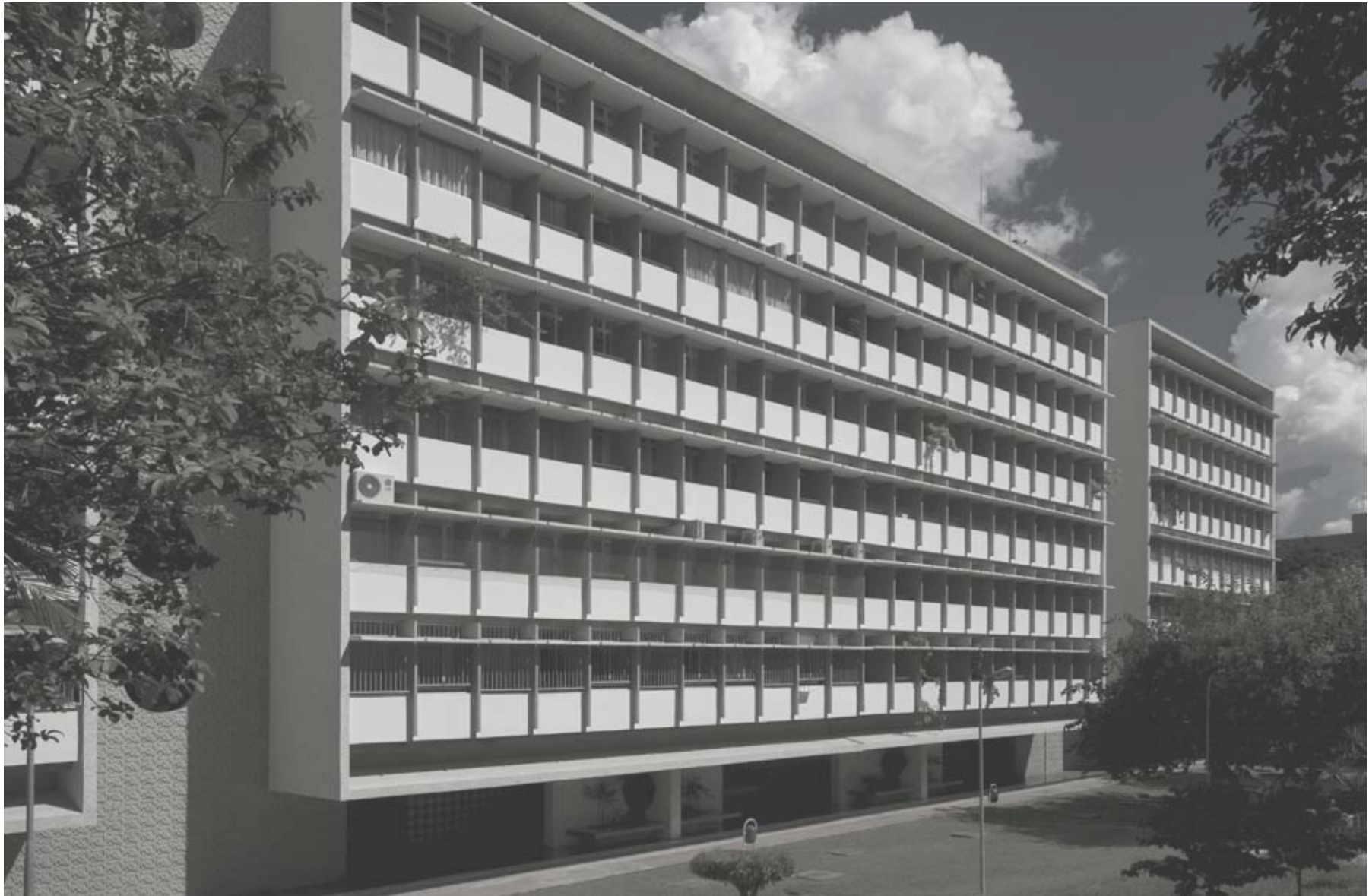
61. Fachada principal. Bloco tipo AM-2, 1975. SQS 210, bloco I. Fonte: autor
