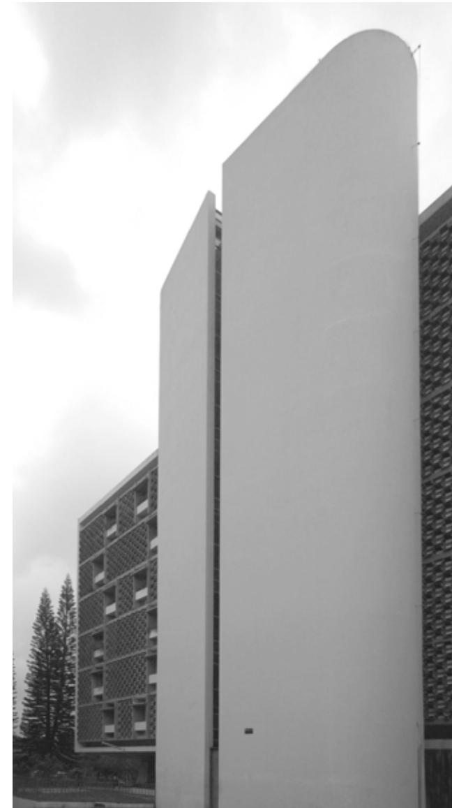
55. Fachada posterior. Bloco tipo AM-3, 1976. SQS 312, bloco F. Fonte: autor
