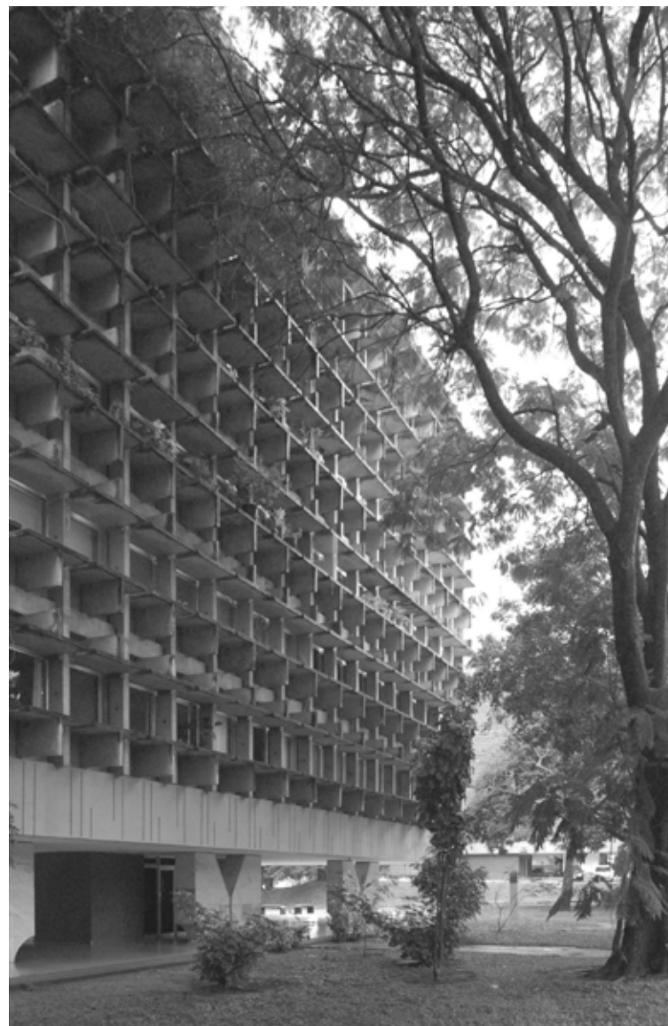
53. Bloco tipo A-22. Detalhe fachada principal. Fonte: autor
