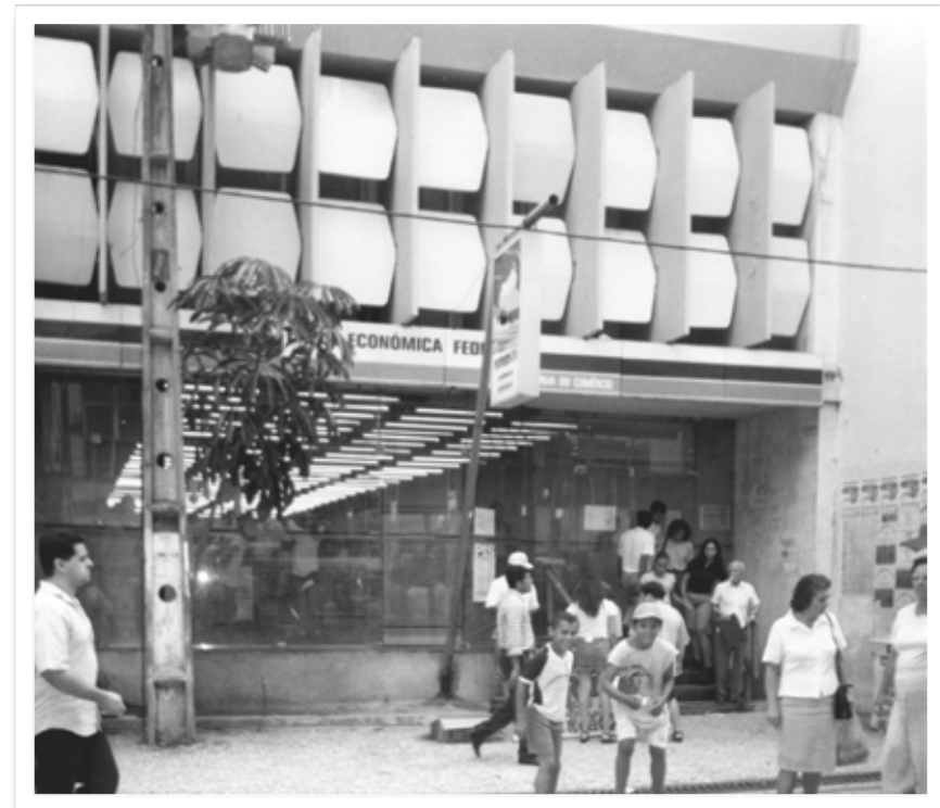
133. Agência Rua do Comércio - fachada principal Fonte: acervo de Marcílio Mendes Ferreira
