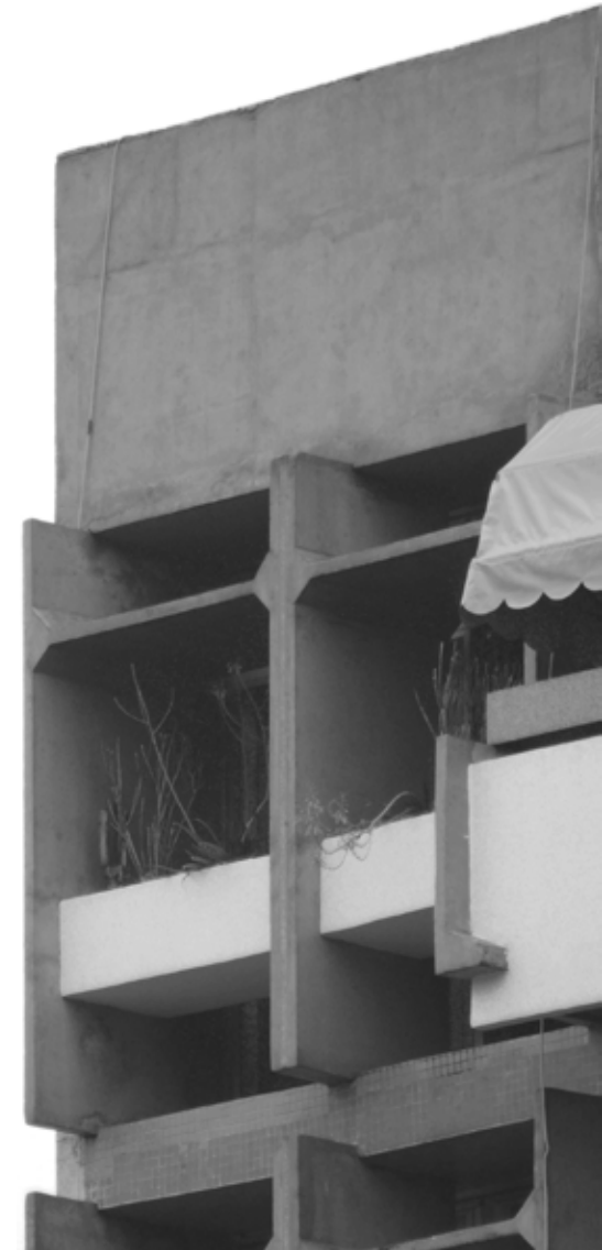
67. Detalhe fachada. Bloco tipo AM-4 Fonte: autor
