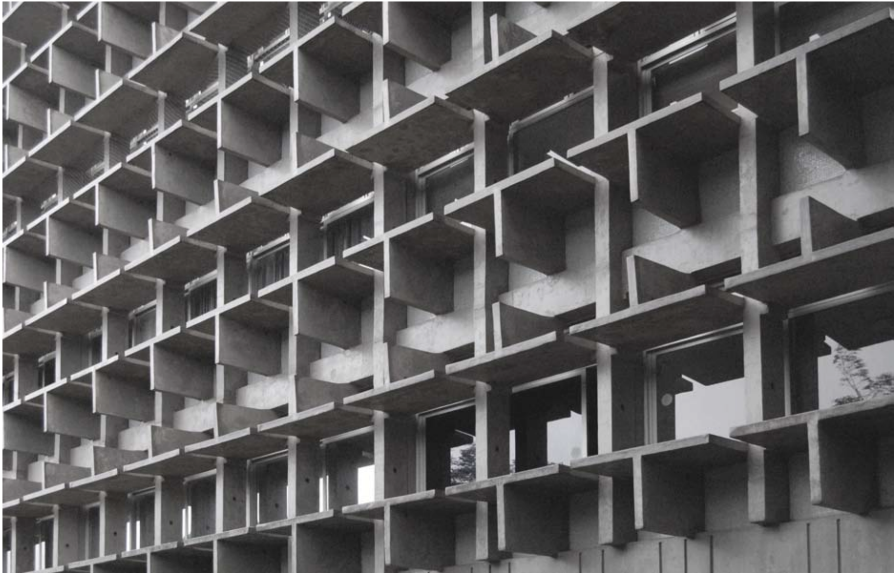
52. Bloco tipo A-22. Detalhe fachada principal. Fonte: autor
