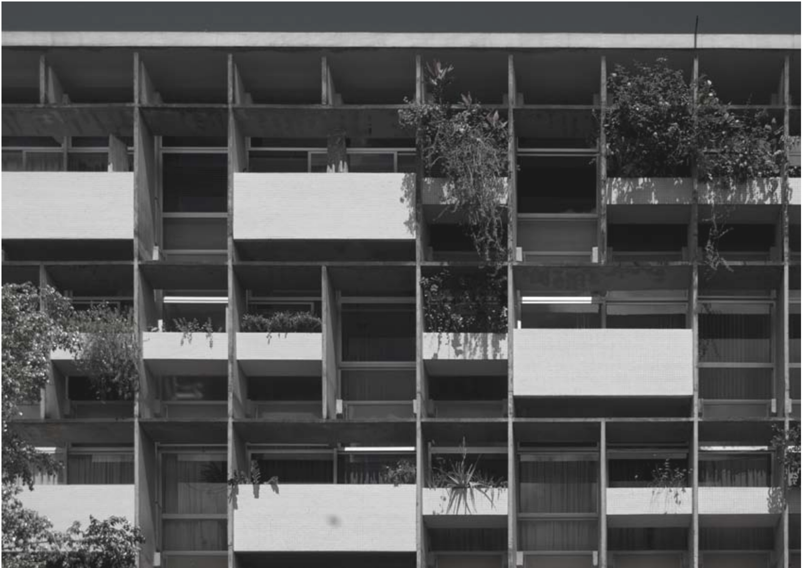
54. Detalhe da fachada. Bloco AM-1, 1975. SQS 309, bloco B. Fonte: autor
