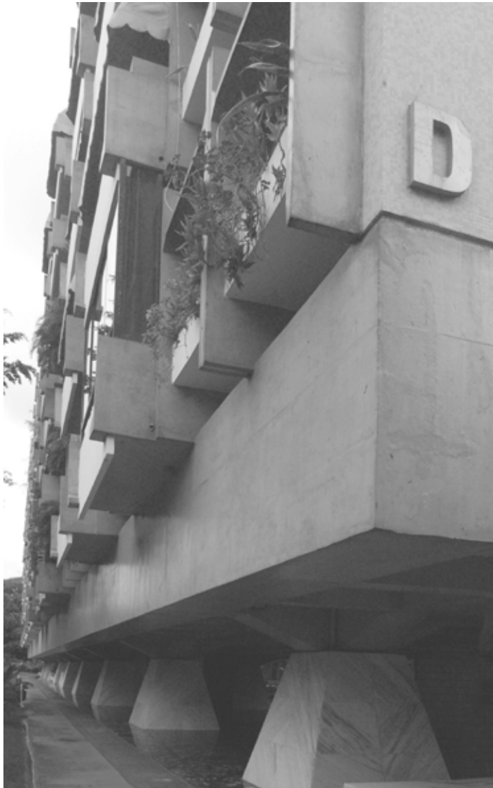
68. Detalhe fachada principal. Bloco tipo AM-4. Fonte: autor
