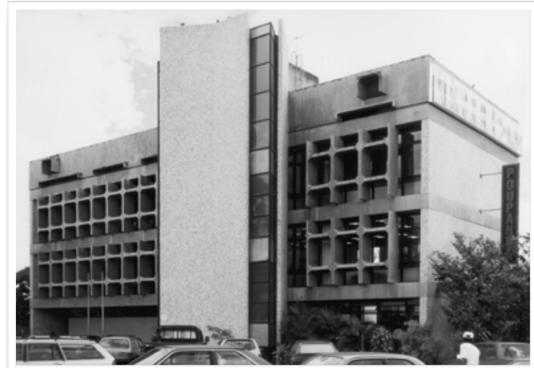
138. Agência Sobradinho -fachada principal Fonte: acervo de Marcílio Mendes Ferreira
