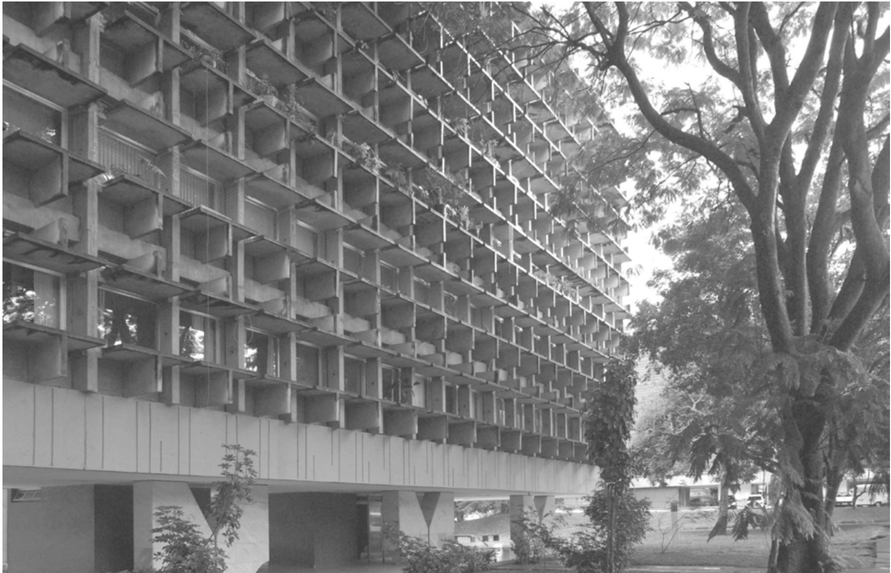
117. Fachada principal - Bloco tipo A-22, SQN 206 Fonte: acervo de Marcílio Mendes Ferreira
