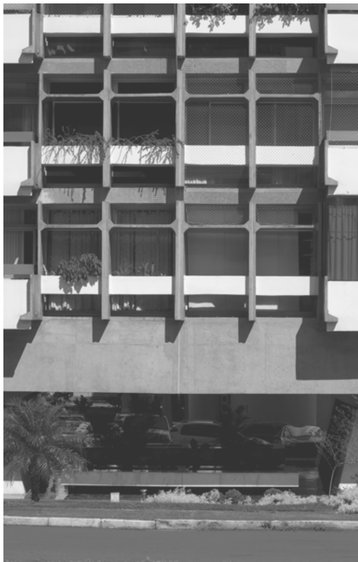
126. Fachada posterior. Bloco tipo AM-4 Fonte: autor
