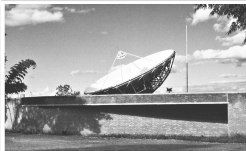
91. Autotrac - detalhe da fachada.
