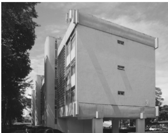
48. Bloco tipo A-18a. Fachada lateral Fonte: autor
