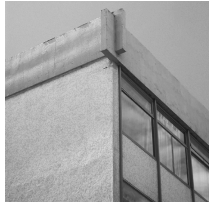
46. Detalhe fachada bloco tipo A-18a. Fonte: autor
