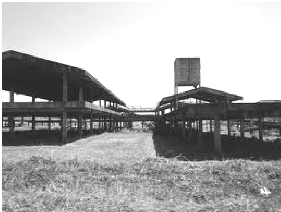
Figura 3: Estrutura de concreto - construção do IFG-campus Inhumas-GO – 1996-2006. Fonte: Relatório de Avaliação do Plano de Expansão da Rede Federal de Educação Tecnológica, 2007.
