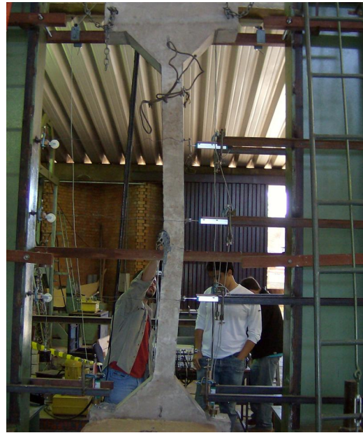
Figura 4.27 – Ruína do pilar PFN 6-3
