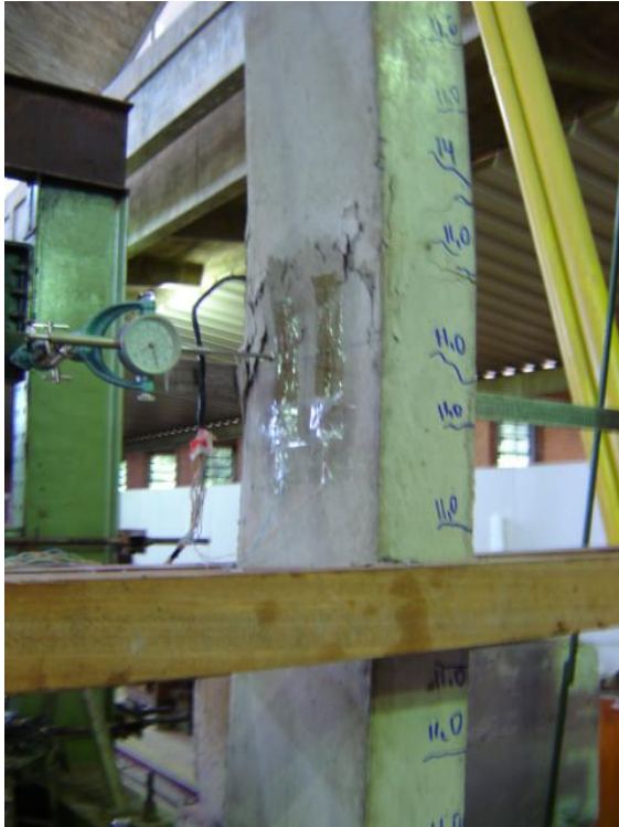
Figura 4.34 – Ruína do pilar PFN 50-3
