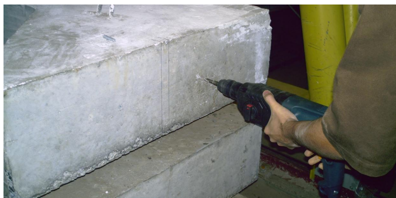
Figura 3.23 – Realização de furos na cabeça do pilar
