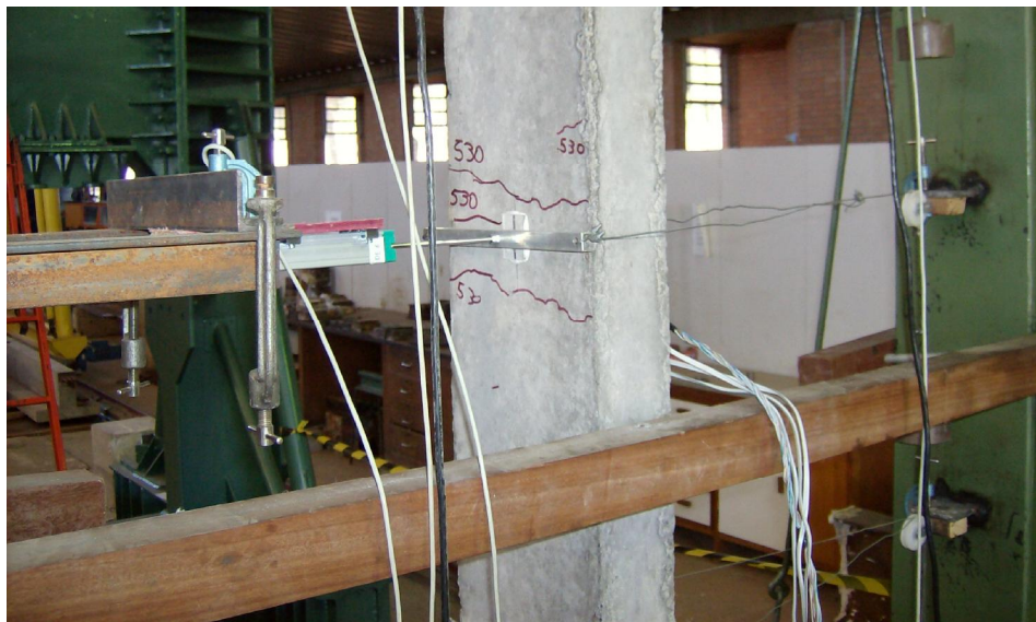
Figura 3.19 – Marcação das fissuras iniciais no pilar PFN 12-3
