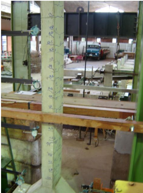
Figura 4.10 – Fissuras do pilar PFN 50-3
