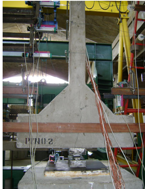
Figura 4.19 – Fissuras do pilar PFN 0-2
