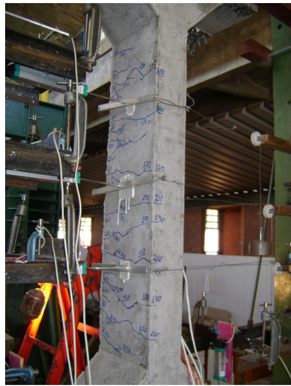
Figura 4.23 – Fissuras do pilar PFN 40-2
