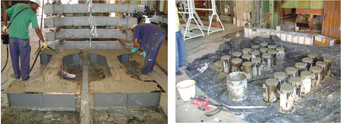
Figura 3.6 – Concretagem dos pilares (esq) e moldagem dos corpos-de-prova (dir.)
