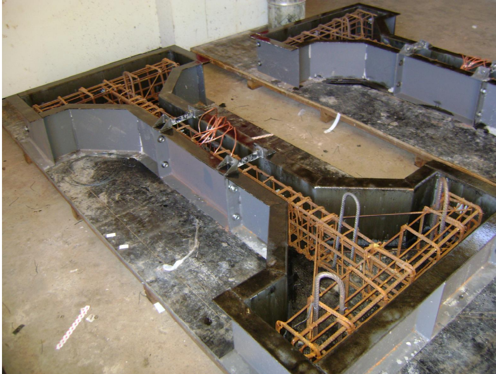
Figura 3.5 – Armadura posicionada na forma com desmoldante
