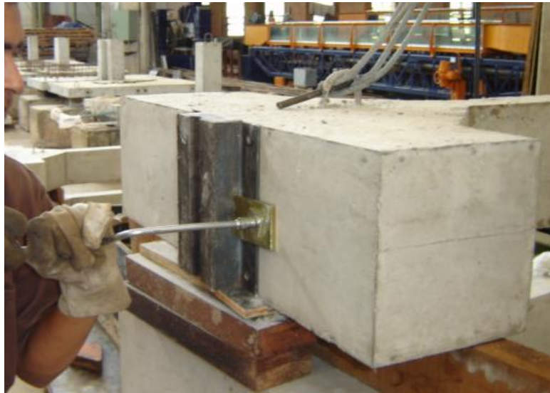
Figura 3.24 – Fixação do aparelho de apoio na cabeça do pilar
