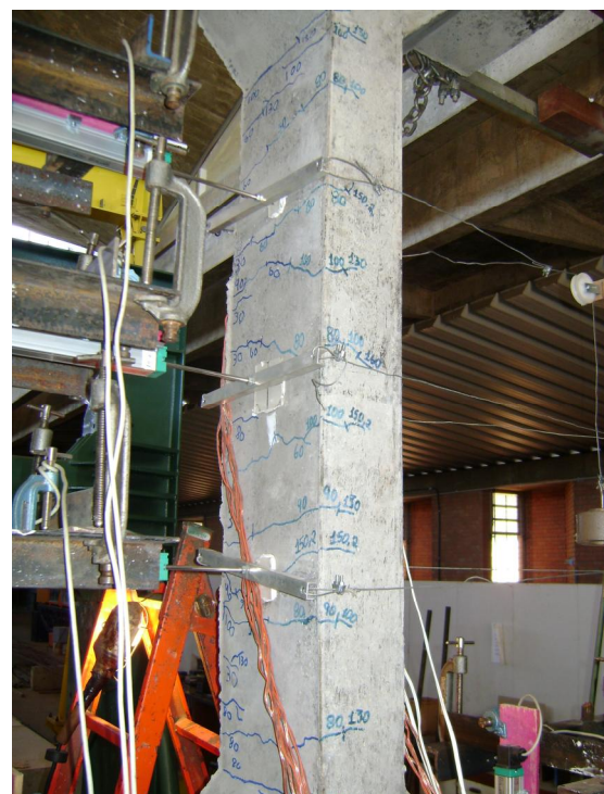
Figura 4.25 – Fissuras do pilar PFN 60-2
