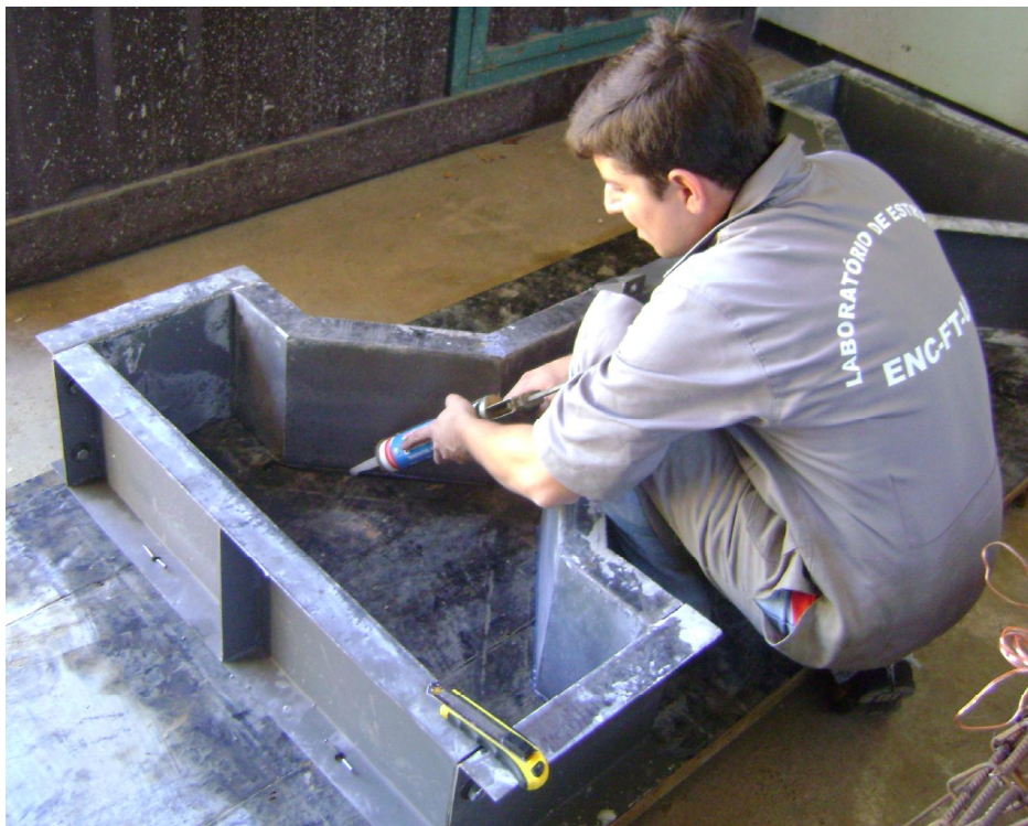
Figura 3.4 – Aplicação de silicone nas frestas entre módulos e fundo
