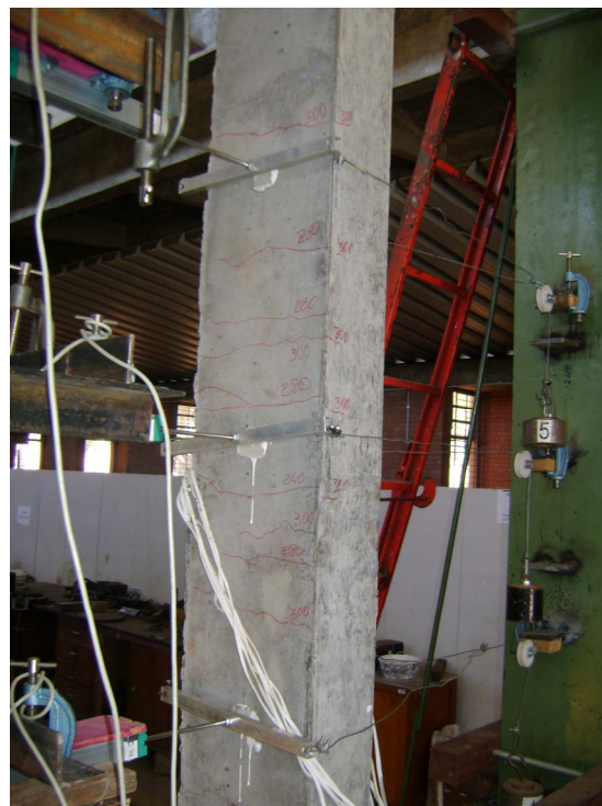
Figura 4.15 – Fissuras do pilar PFN 30-2,5
