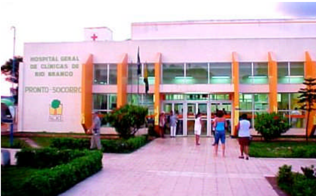
IMAGEM 04 – Fotografia do Hospital Geral Clínicas de Rio Branco/AC, depois de finalizar a reforma que recebeu recursos do Projeto Reforsus, em 2002.
