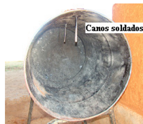
Figura 9.1. Foto dos canos soldados na parte interna do tonel (poços de visita).
