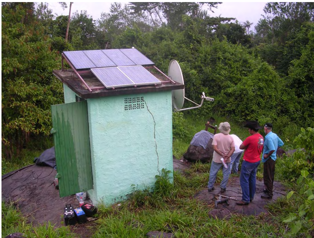
Fig. 1.6 - Estação PDRB, durante os trabalhos de implantação da transmissão por satélite para Brasília. A estação está instalada sobre afloramento de granito/gnaíse no interior da Bacia (Nakayoshi, 2005).
