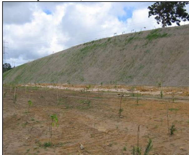
Figura 5.38 - Recuperação de Taludes e Áreas de Empréstimos.(Consórcio Skill-STE).
