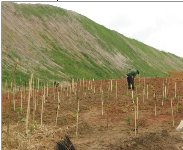
Figura 5.36 - Plantio de taludes e faixas de domínio. Prevenção de processos erosivos.
