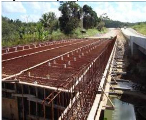
Figura 5.33 - Implantação de Obras de Arte.
