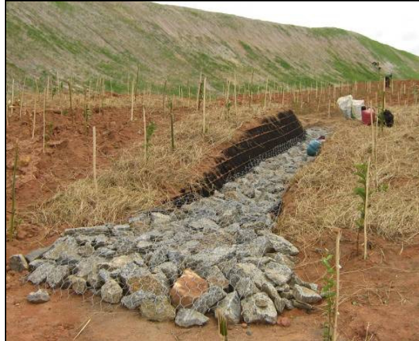
Figura 5.39 - Implantação de dissipadores de energia.
