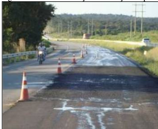
Figura 5.34 - Pavimentação. Interdição de pista.
