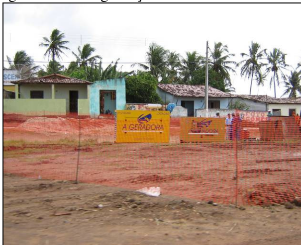
Figura 5.11 - Degradação das Áreas Urbanizadas.
