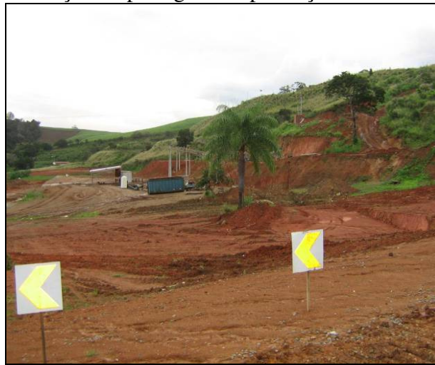
Figura 5.14 - Alteração da paisagem. Implantação de um canteiro de obras.
