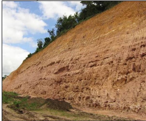
Figura 5.27 - Talude instável.
