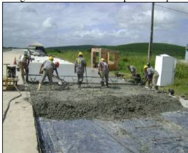
Figura 5.35 - Atividades de pavimentação.
