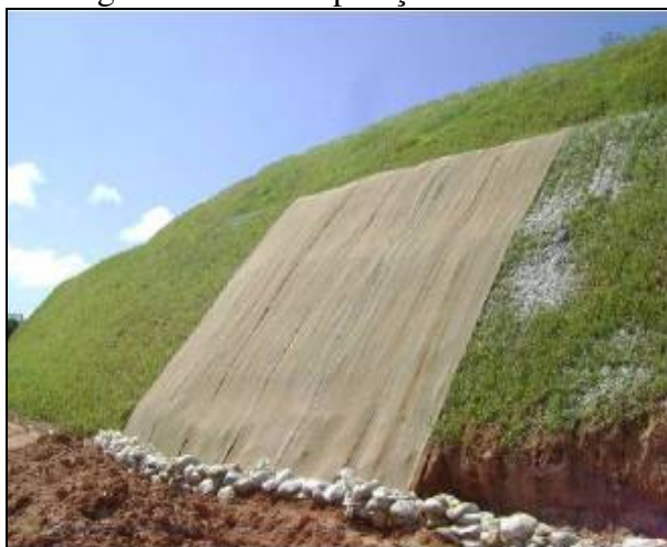
Figura 5.37 - Recuperação de Taludes.
