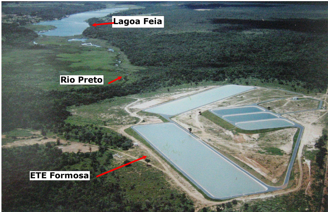
Figura 6.5 – Imagem da ETE Formosa, a Lagoa Feia, ao fundo, e a nascente do Rio Preto
