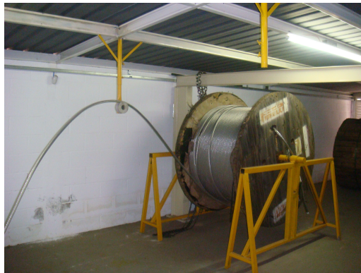
Figura 3.20 – Retirada do cabo condutor da bobina
