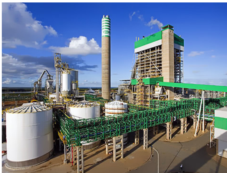
Figura 3-5 Central de cogeração qualificada Veracel, com 117 MW de capacidade utilizando licor negro como combustível, em Eunápolis/BA (foto: Veracel Celulose S.A.).
