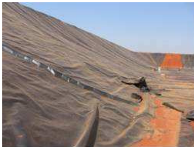
Figura 1.2 - Detalhe de talude revestido com geomembrana durante a execução de uma lagoa de estabilização de resíduos.
