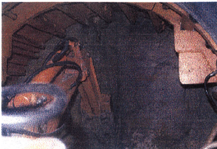
Figura 2.6 - Vista interna de uma shield de frente aberta, ou hand-digging shield, em operação
