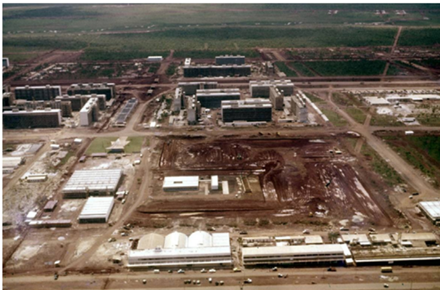
Figura 6.1: Fotografia da construção das edificações e vias da primeira unidade de vizinhança de Brasília
