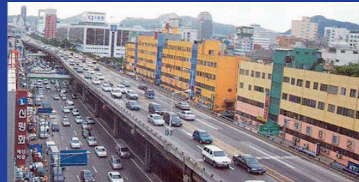
Figura 19 – Antes: via elevada para facilitar o deslocamento dos modais motorizados
