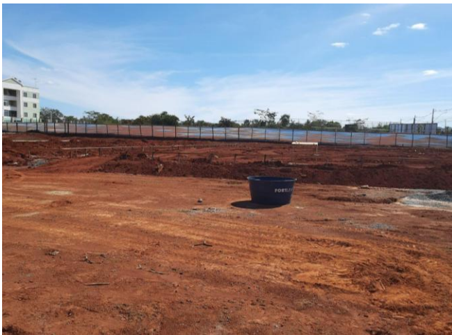
Figura 12 - Área da construção de uma das escolas. Fonte: imagem autoral.
