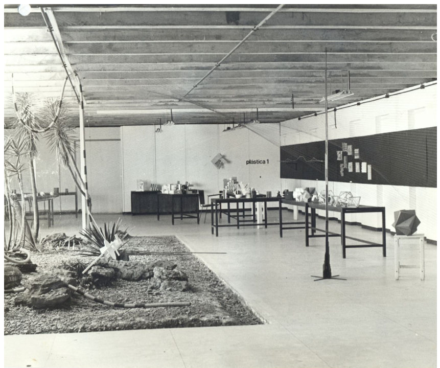
Figura 57. Exposição no Instituto Central de Artes, SG-1. Por essa imagem é possível compreender parte do aspecto interior dos pavilhões SG: espaços amplos e desimpedidos, jardins abertos e arquitetura determinada pelas vedações portantes e vigas protendidas. Fonte: Arquivo Central da UnB.
