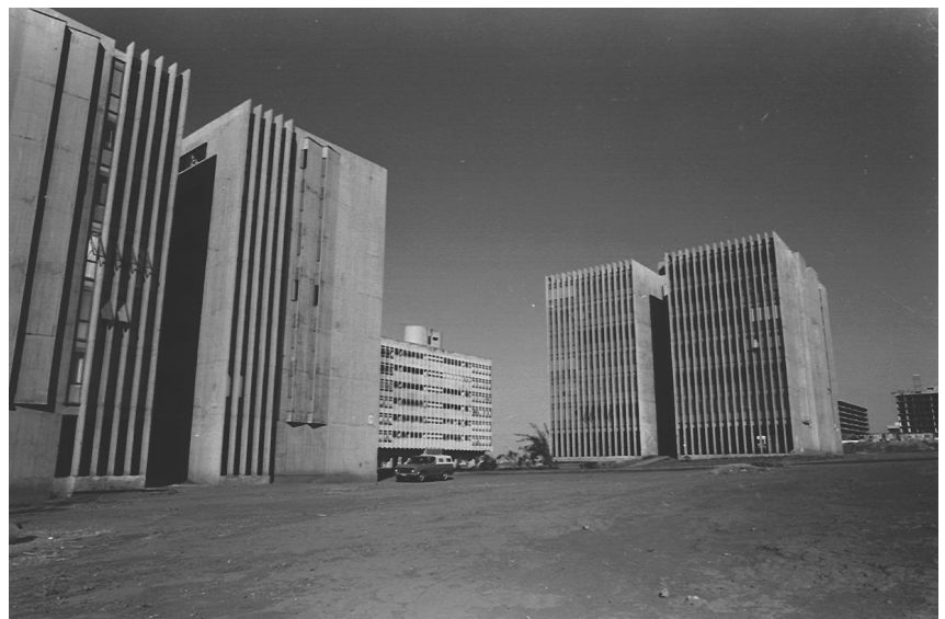
Figura 43. Blocos da SQN 107 após a conclusão das obras. Em primeiro plano, dois blocos projetados por Mayumi Watanabe de Souza e Lima e Sérgio de Souza Lima. Fonte: Arquivo Central da UnB.
