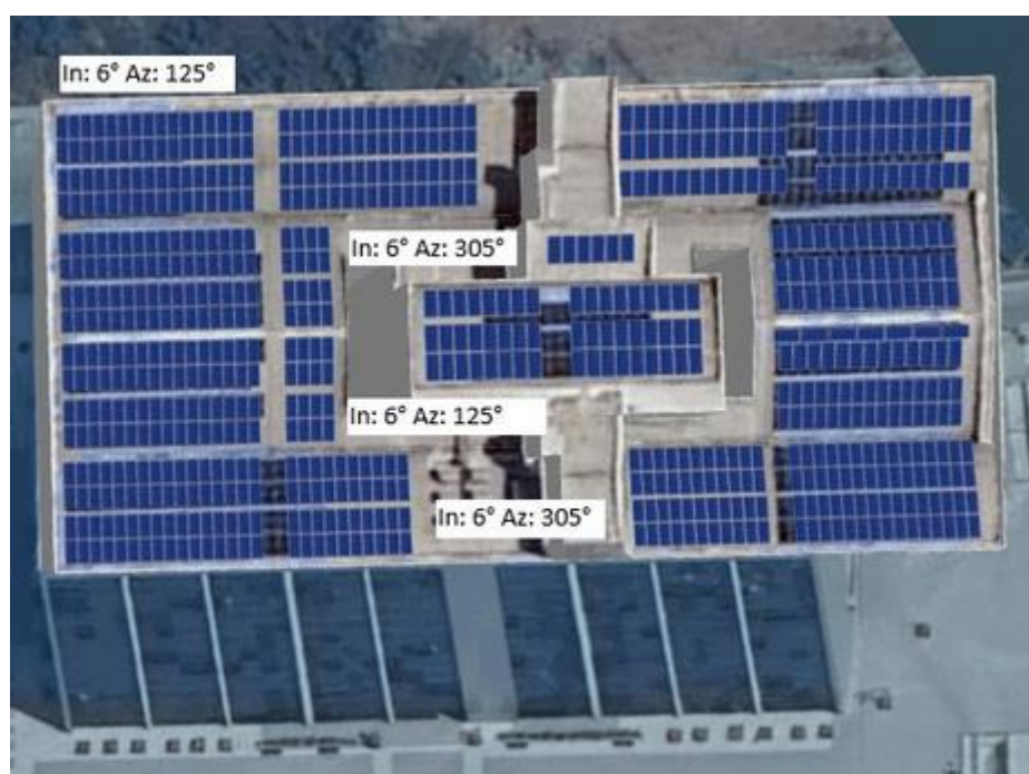
Figura 4.5 – Reestruturação do sistema fotovoltaico do cenário CEZ-4.
