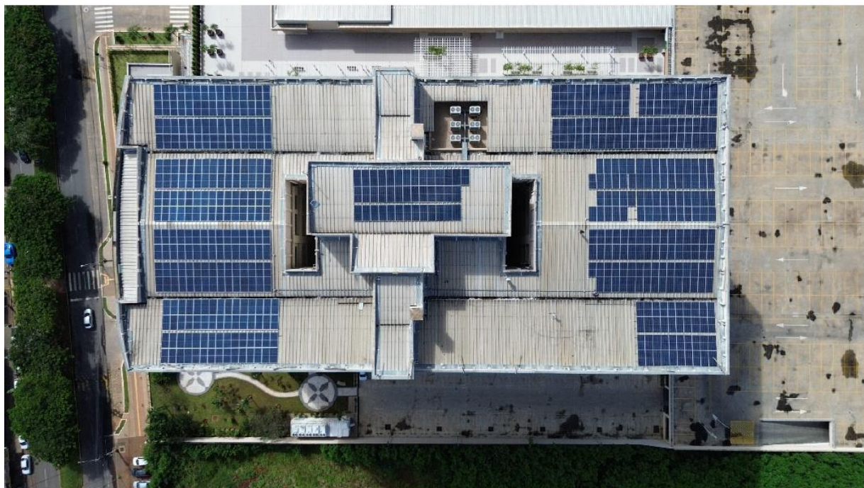
Figura 3.13 – Vista da cobertura com disposição das placas fotovoltaicas existentes.
