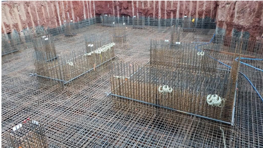
Figura 3.64. Organização dos cabos nos pilares do fosso do elevador antes da execução da primeira etapa de concretagem.
