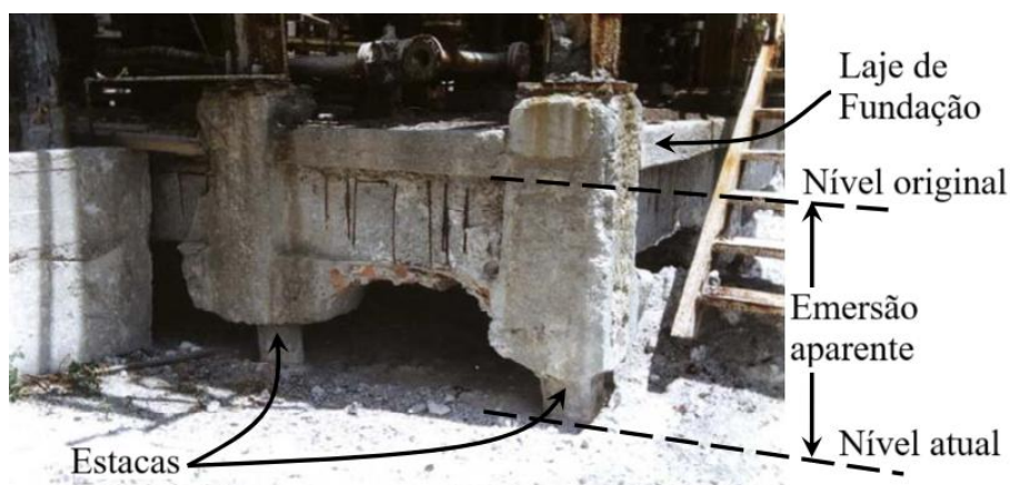
Figura 2.6. Emersão aparente de um grupo de estacas de ponta no lago de Texcoco no México (modificado de Rebolledo, 2010).
