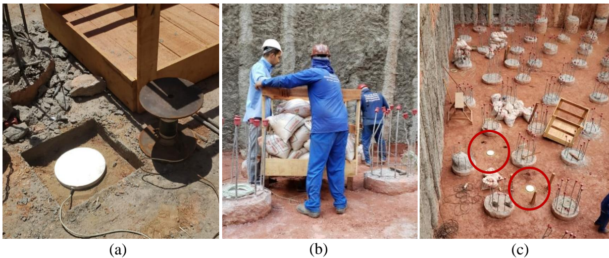
Figura 3.46. Instalação das CTTs: (a) CTT, Célula de carga e cargueira, (b) aplicação de cargas com cargueira, e (c) posicionamento de 2 células anteriormente ao lastro (círculos vermelhos).
