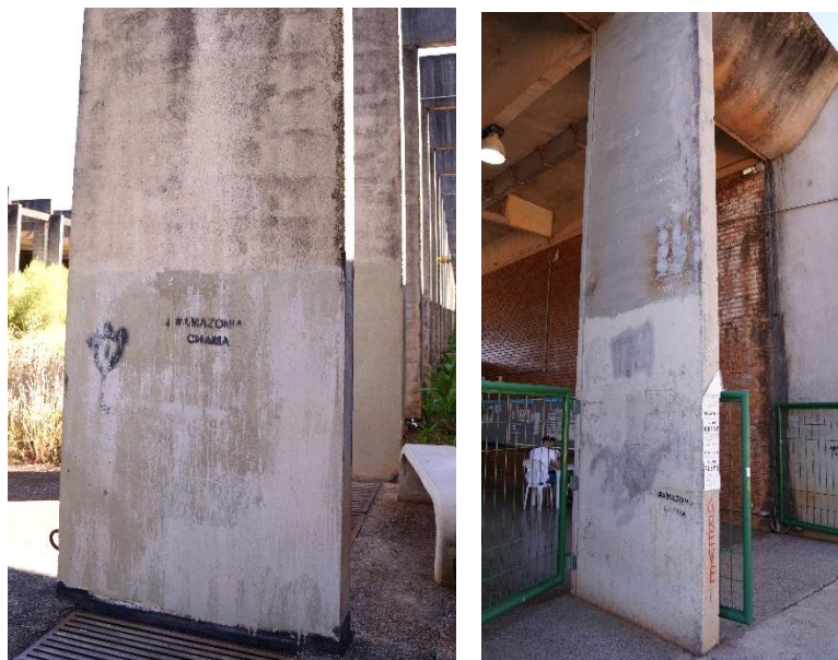
Figura 46 – Pintura em tonalidade clara no concreto aparente. Fonte: da autora.
