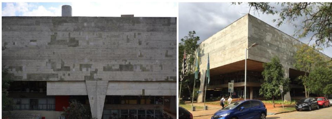
Figura 23 – Execução de intervenção na empena com alterações na coloração original do Concreto na FAUUSP.
