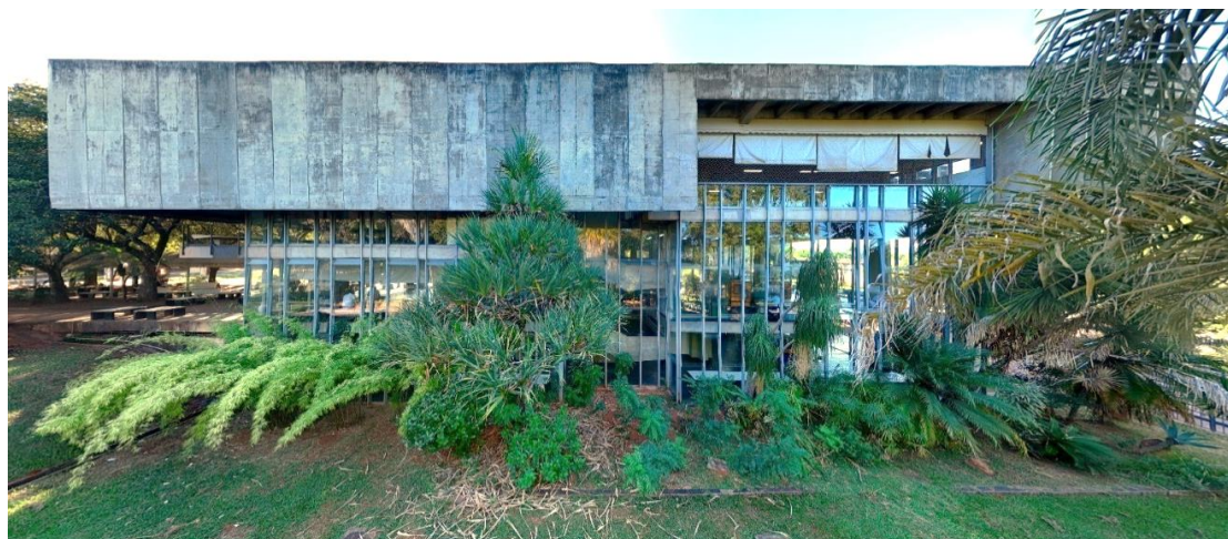
Figura 79 - Fachada Sudeste do RU. Fonte: da autora.
