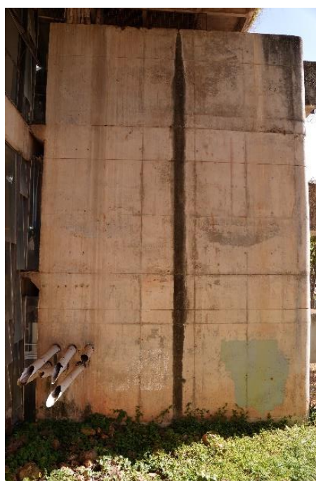
Figura 67 – Mancha de crosta negra ( C_i = 1 ). Fonte: da autora.
