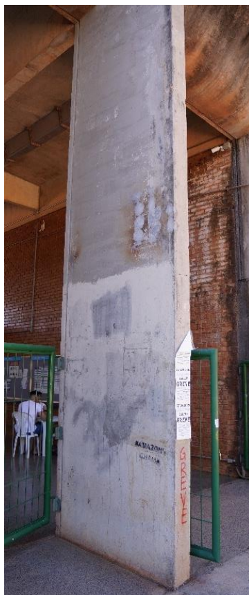
Figura 68 – Mancha de crosta negra ( C_i = 2 ). Fonte: da autora.
