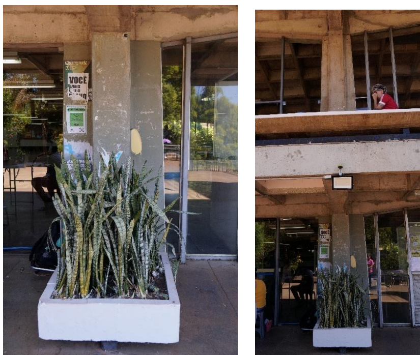
Figura 89 – Fotos de Pilar a diferentes distâncias do elemento (a aproximadamente 3 m à esquerda e a 6 m à direita).
