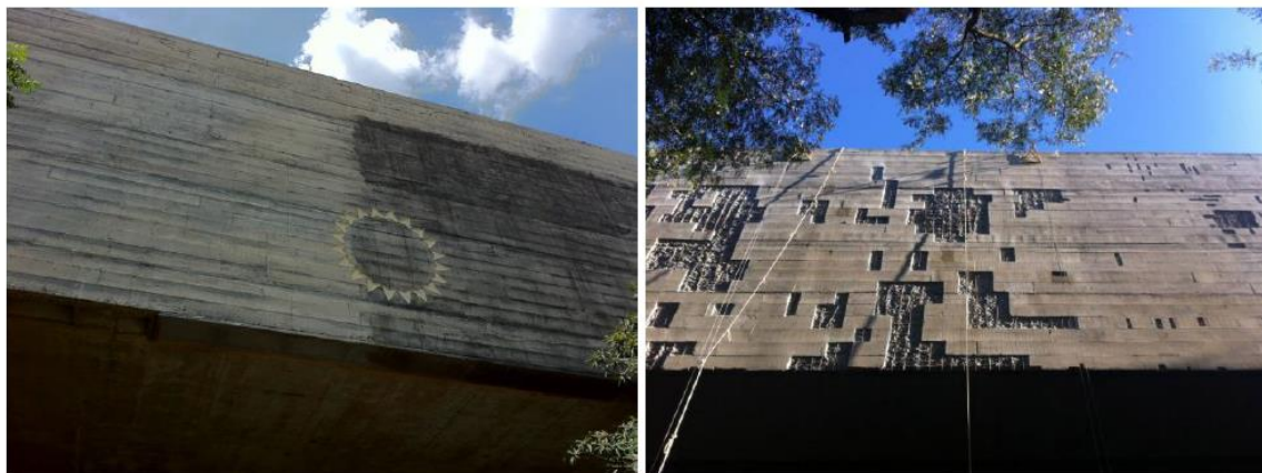
Figura 22 – Limpeza por hidrojetamento e escarificação da empena de concreto da FAUUSP. Fonte: Fonte: (CASTRO et. al., 2016).
