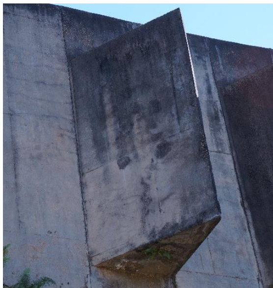
Figura 69 – Mancha de crosta negra ( C_i = 3 ). Fonte: da autora.
