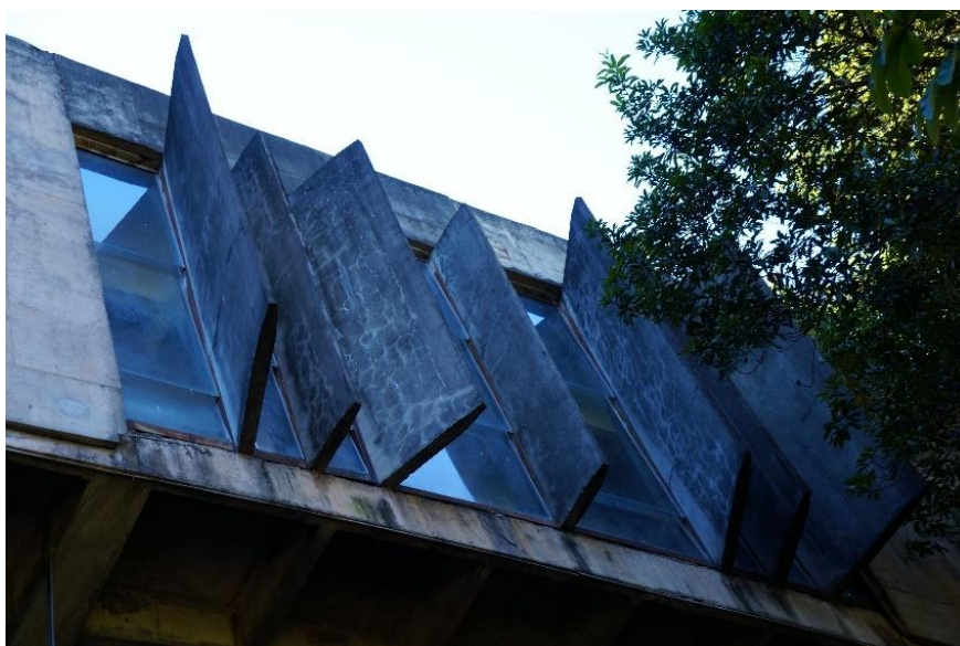
Figura 117 – Brises B34 a B40 na fachada sudoeste.
