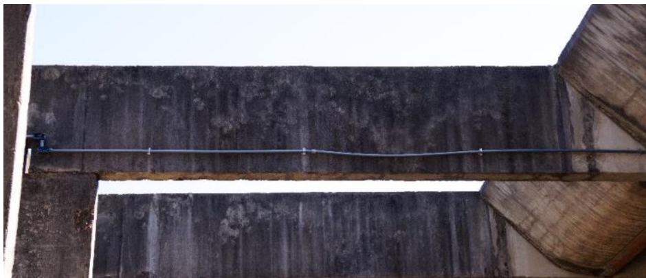
Figura 70 – Mancha de crosta negra ( C_i = 4 ).
