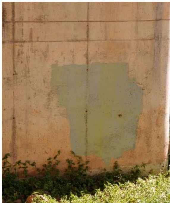
Figura 63 – Pintura ( C_p = 2 ) a 3 m de visualização. Fonte: da autora.
