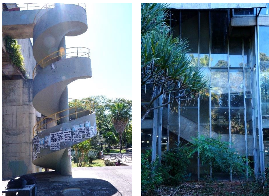
Figura 128 – Escada exposta na fachada nordeste (esquerda) e presença de vidros de proteção a agentes externos na fachada sudeste (direita).
