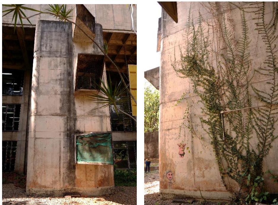
Figura 126 – Paredes PR10 (esquerda) e PR11 (direita) na fachada sudoeste.
