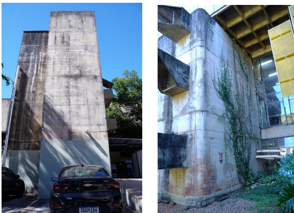
Figura 129 – Paredes de concreto da fachada noroeste (à esquerda) e da fachada sudoeste (à direita).
