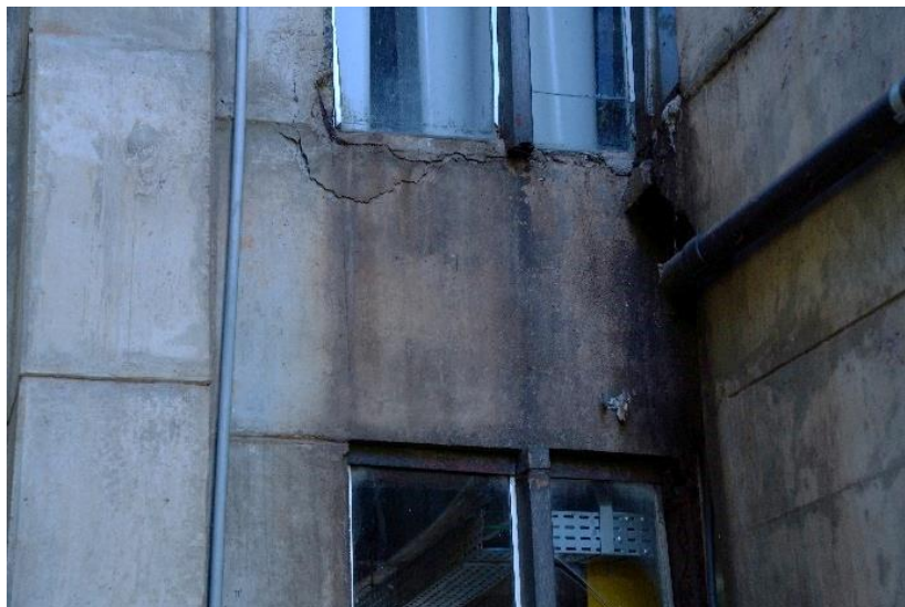
Figura 65 - Pintura ( C_p = 4 ) a 3 m de visualização. Fonte: da autora.
