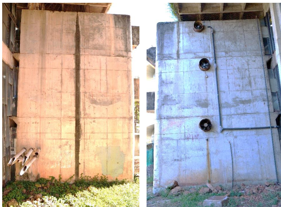
Figura 124 – Paredes PR1 (esquerda) e PR3 (direita) na fachada nordeste.
