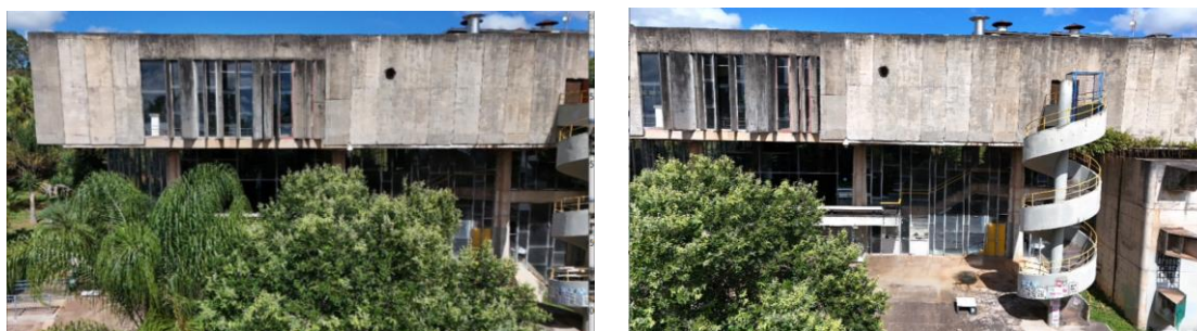
Figura 88 – Fotos do painel PN1 tiradas com drone a uma distância de aproximadamente 9 m do elemento a cada 3 m.
