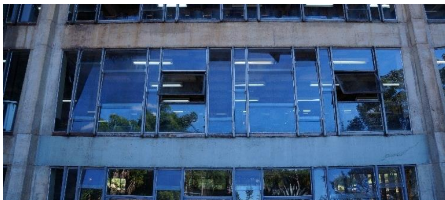
Figura 64 - Pintura ( C_p = 3 ) a 6 m de visualização. Fonte: da autora.
