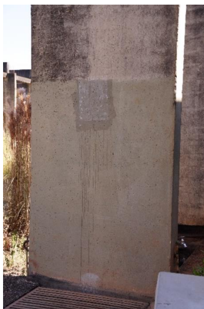
Figura 62 – Pintura ( C_p = 1 ) a 3 m de visualização.
