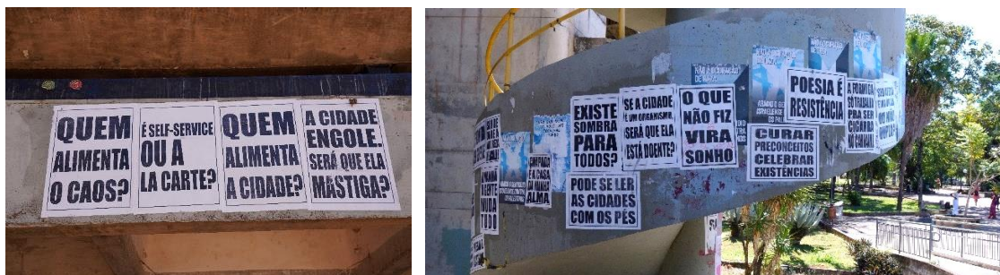
Figura 45 – Cartazes colados no concreto aparente. Fonte: da autora.
