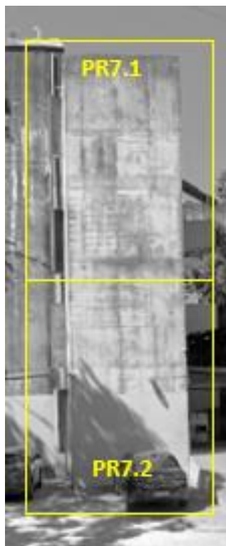
Figura 96 - Divisão do painel PR7 em dois subelementos: PR7.1 e PR7.2. Fonte: da autora.
