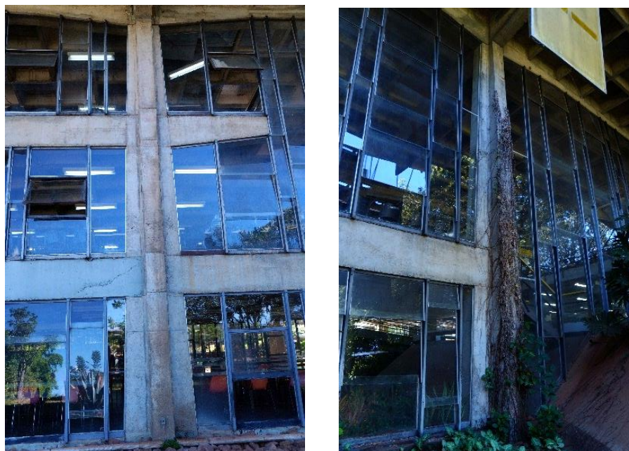
Figura 114 – Pilar P5 (à esquerda) e pilar P12 (à direita).
