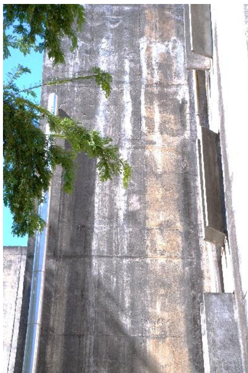
Figura 125 – Parede PR5 na fachada noroeste.
