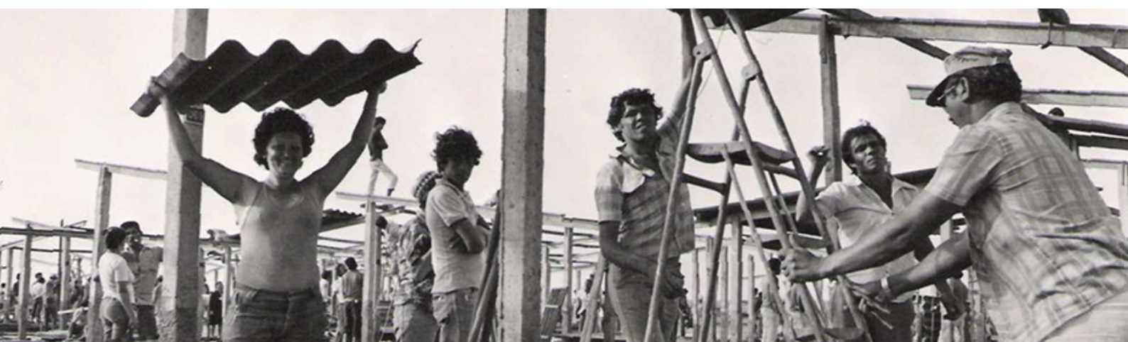
Figura 27 - Montagem da Feira Central de Ceilândia nos anos 1970.
