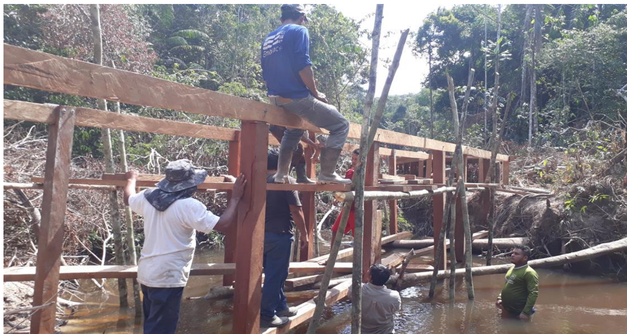
Figura 32: Comunidade reunida em mutirão para a construção da ponte sobre o igarapé painen
