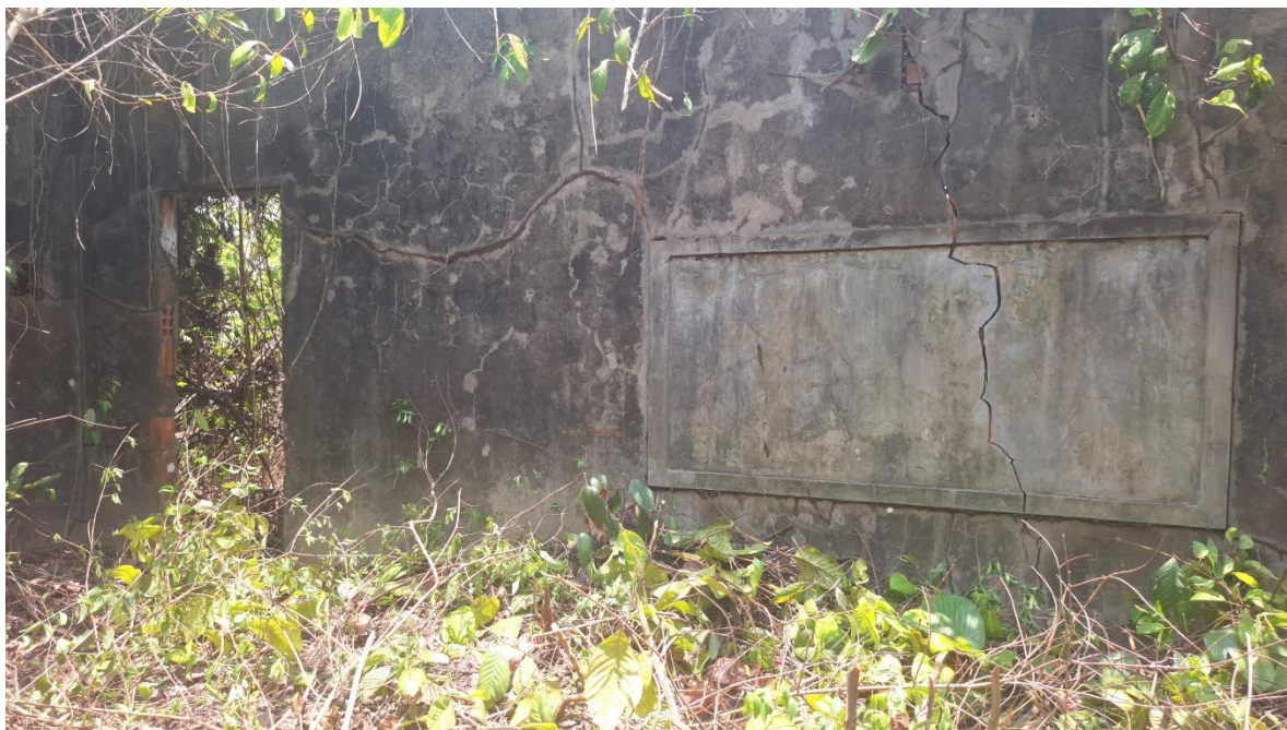
Figura 11: Ruína da escola construída para os colonos com sala e quadro de giz
