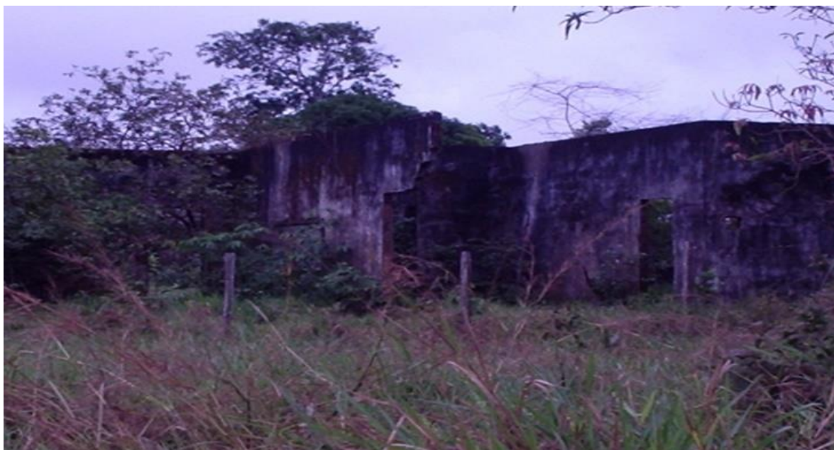
Figura 10: Ruína da escola construída pelo prefeito da época, Valdizão, para os colonos
